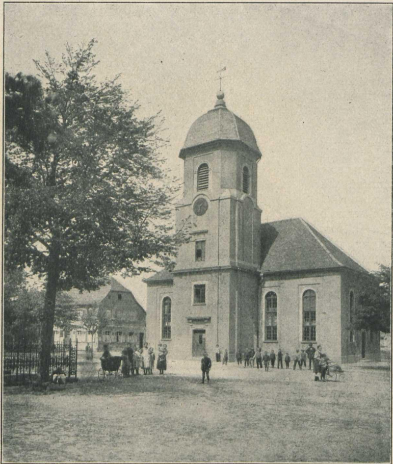
4. Kirche in Mühlburg bei Karlsruhe (vor dem Umbau)
