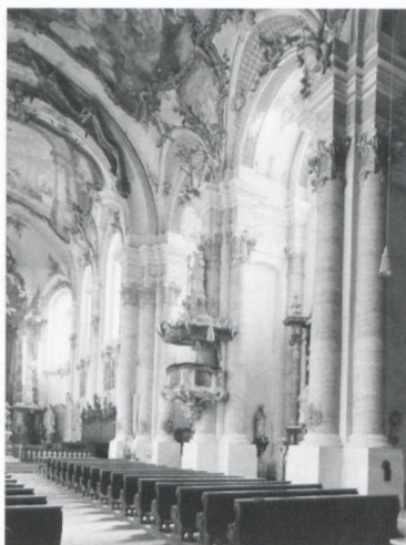
Abb. 20: Vorbild für das Kapellensystem der Schongauer Stadtpfarrkirche: Neustift bei Freising, ehem. Prämonstratenser-Klosterkirche St. Peter und Paul, um 1700 erbauter Wandpfeilersaal, 1751 im Gewölbereich wahrscheinlich durch Johann Baptist Gunetzhainer erneuert, Wandpfeilerreihe auf der Südseite (Bildarchiv BLfD)
