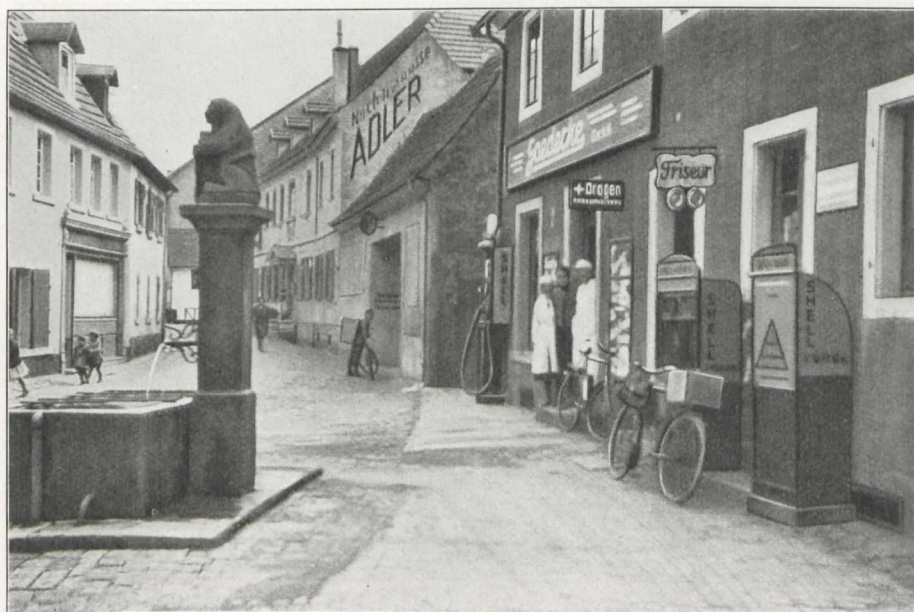
4. Platzartige Erweiterung eines Dorfes. Hinter dem schönen Löwenbrunnen ein Filialgeschäft: Schild, Haustüre und Rolladen in den Hausfarben dieses Geschäftes: Weiß und Ultramarin, daneben Shell-Zapfsäule und zwei mannshohe Ölbehälter, alles in den Hausfarben Shell: Schwefelgelb mit Signaltrot.
