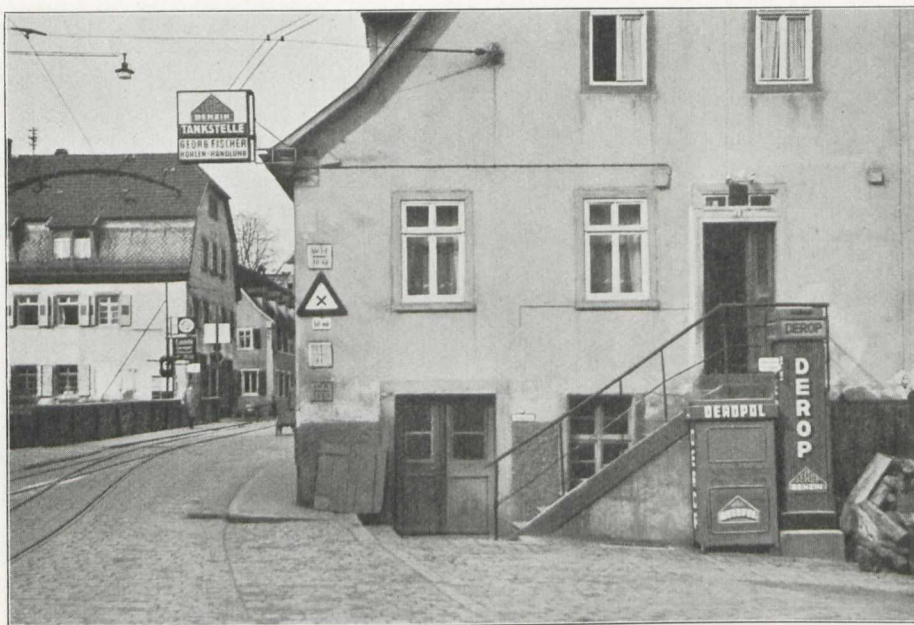
3. 40 Schritte weiter (von Bild 2). Am Giebel schwebt ein Leuchtkasten, an der Treppe kleben eine orangefarbige Derop-Zapfsäule mit einem ebenso grell gestrichenen Ölfanister. 30 Schritte weiter folgt daselbe in schwefelgelb mit signalrot: Schell. Niemand will auch nur eines dieser schreienden Reklamezeichen wegnehmen.
