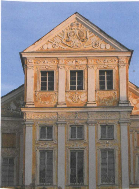
7. Zamek w Nieświeżu. Elewacja frontowa, 2002 r. (przed konserwacją). Fot. Tadeusz Bernatowicz / Nesvizh Castle. Front facade, 2002 (before renovation). Photo Tadeusz Bernatowicz
