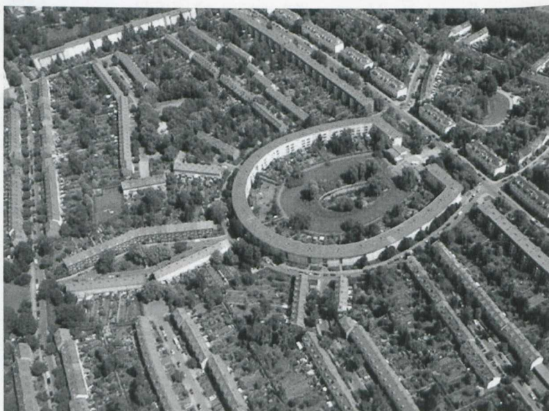
8. Nucleo residenziale Hufeisensiedlung Britz della GEHAG a Berlino, progettato da B. Taut e M. Wagner (1925-26) come esempio di costruzioni abitative estensive
