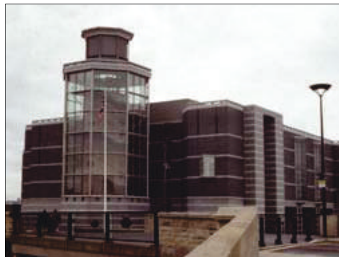
23. Królewskie Zbrojownie w Leeds, proj. D. Walker
