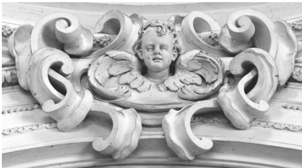
Il. 9. Tarłów, kościół parafialny, kartusz nad pld. ścianą tarczową w kaplicy płu. (fot. M. Kurzej).
