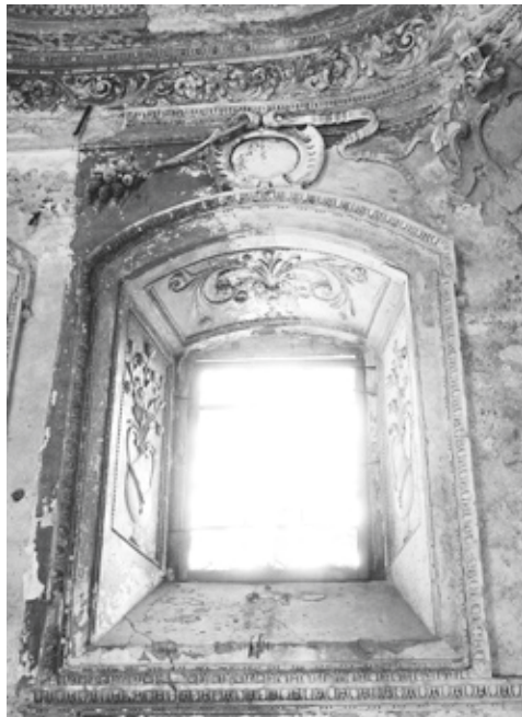
Il. 11. Podkamień, kaplica św. Dominika (Cetnerów), wnęka okienna w ścianie płd. (fot. M. Kurzej).
