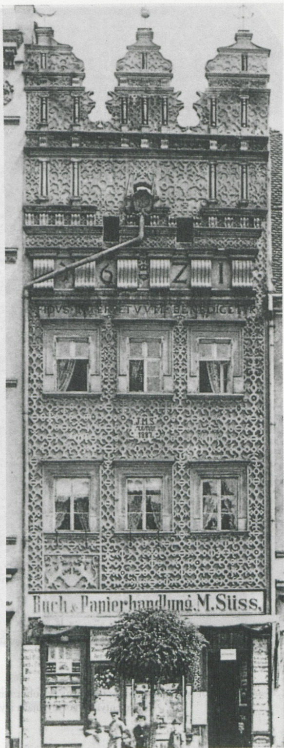
6. Brzeg, kamienica w Rynku z 1621 (stan sprzed 1945) — przykład osobliwego zastosowania ornamentyki niderlandzkiej w architekturze
