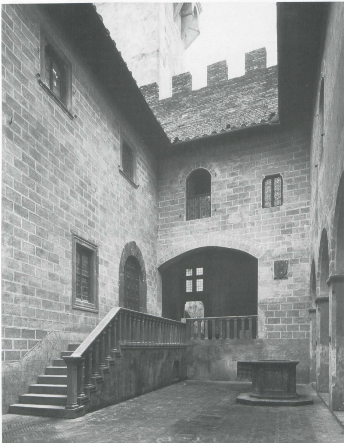
9-10 Montegufoni, Villa Acciaioli, Cortile vecchio von Norden und von Süden.
