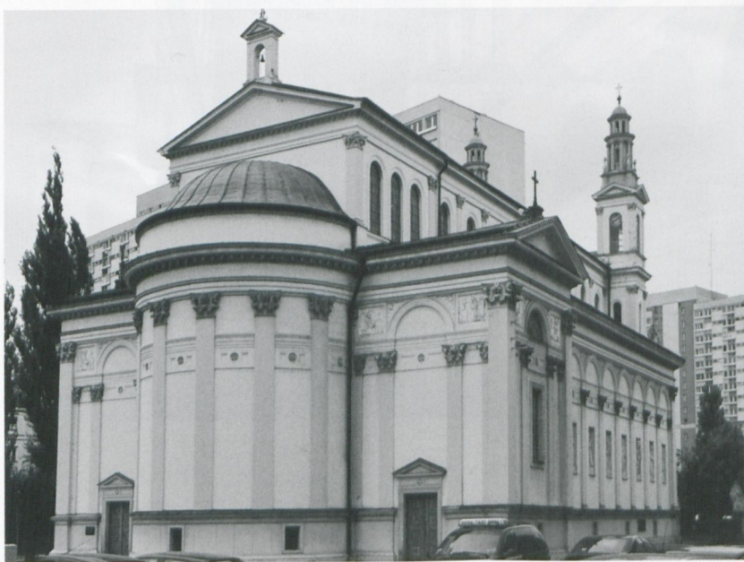
8. Warszawa, kościół na Chłodnej, widok od pn.-wsch., fot. M. Kurzej 2012
