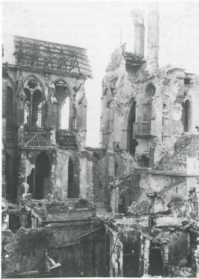
2. Soissons, Kathedrale; Blick von Norden auf Langhaus und Fassade nach der Zerstörung im 1. Weltkrieg
