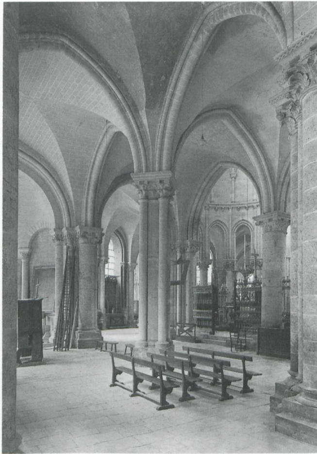
7. Blois, St. Lomer; kantonierte Pfeiler im Chorseitenschiff
