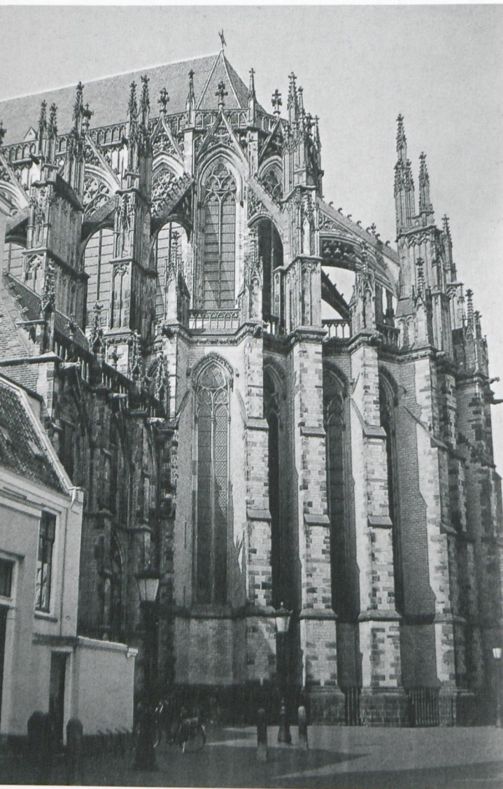
45 Utrecht, Dom St. Martin, Chor von Südosten
