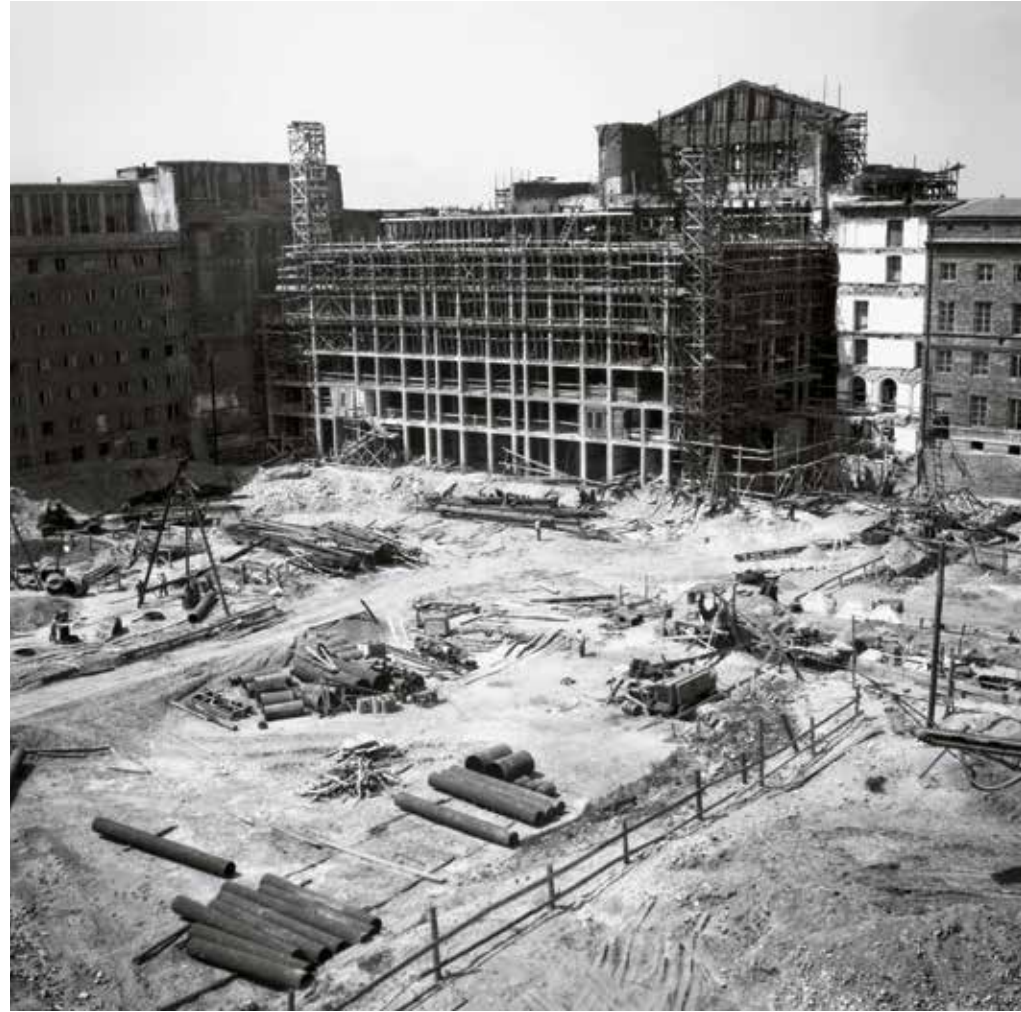
Wykop pod widownię, scenę i zaplecze, widoczny szkielet stalowo-żelbetowy części recepcyjnej, widok od ulicy Trębackiej – odbudowa Teatru Wielkiego, fot. ze zbiorów Narodowego Archiwum Cyfrowego
