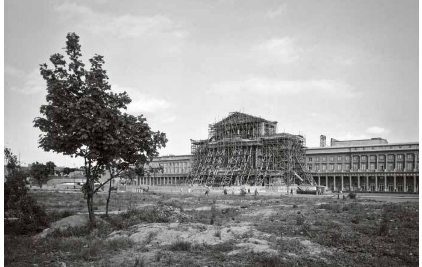
Elewacja główna podparta stemplami – odbudowa Teatru Wielkiego, fot. ze zbiorów Narodowego Archiwum Cyfrowego
