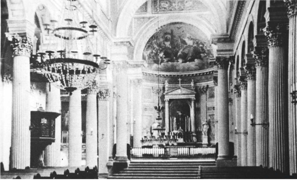
3. Warszawa, kościół na Chłodnej, wewnątrz, widok od zach., fot. przed 1939
