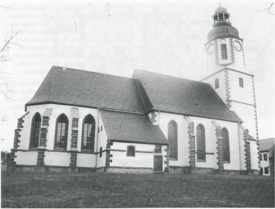
Abbildung 1 St. Michael Frohburg, Ansicht von Nordosten (Foto: Stefan Bürger).
