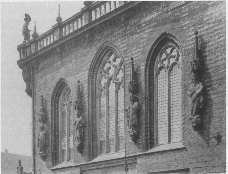
Abb. 42 Bremen, Rathaus, Ostfassade, 1405–1407
