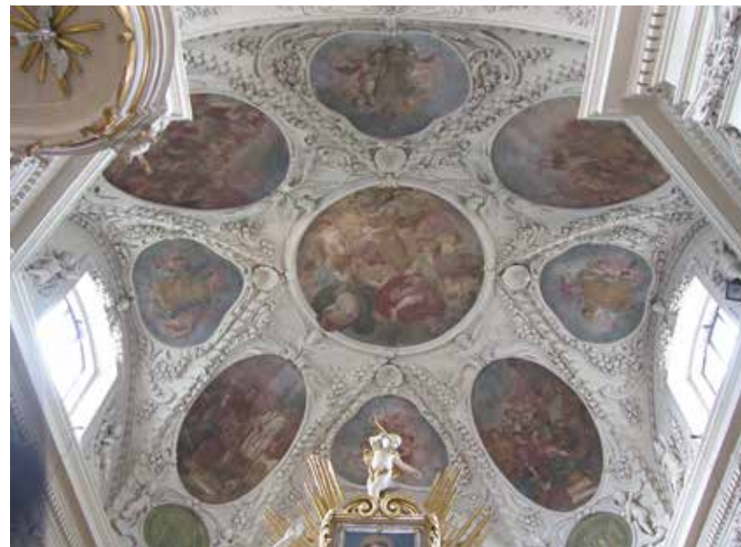
85. Czerniaków, kościół Bernardynów, sklepienie prezbiterium
