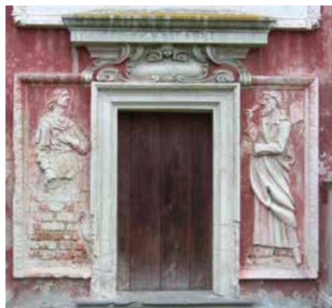
7.6. Obramienie wejścia w elewacji pn.
