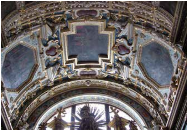
3.22. Sklepienie kaplicy św. Romualda
