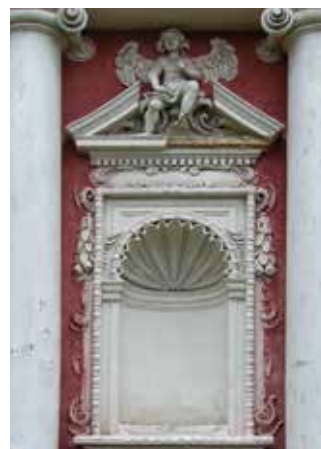
7.9. Nisza w elewacji pd.
