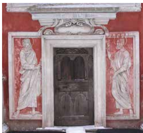
7.7. Obramienie wejścia w elewacji pd.
