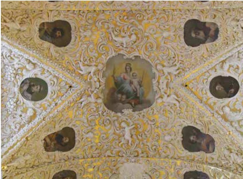
12.4. Środkowe prześło sklepienia
