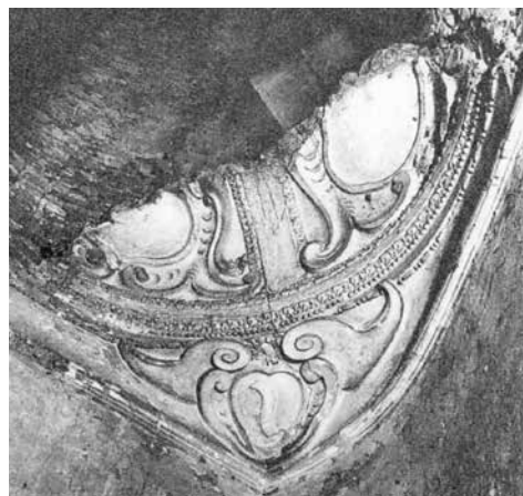
64.2. Gabinet w baszcie pn., fragment dekoracji sklepienia, stan przed restauracją
