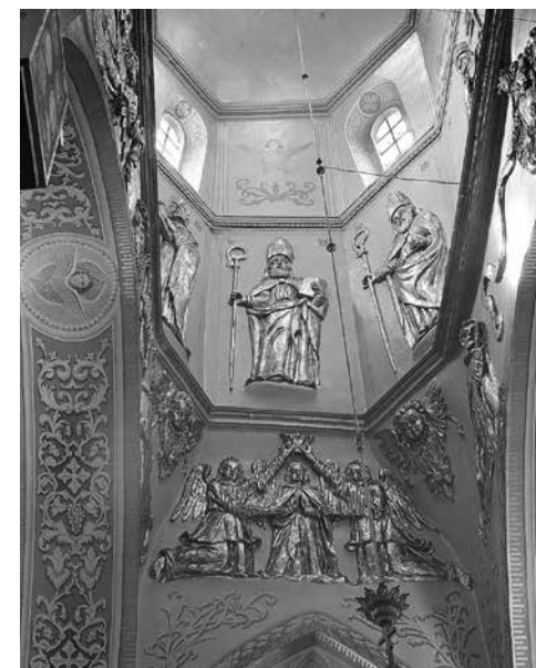
77.4. Dekoracja przęsła krzyżowego, widok od pd.
