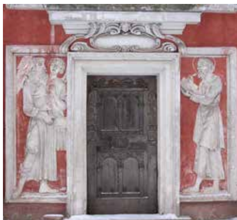
7.5. Obramienie wejścia w elewacji pn.
