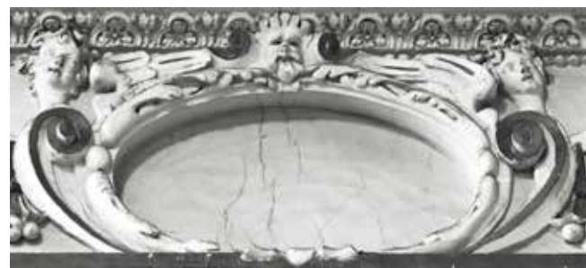
3.19. Obramienie otworu we fryzie nawy
