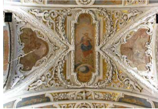
14.5. Sklepienie nawy gł., przęsło wsch.
