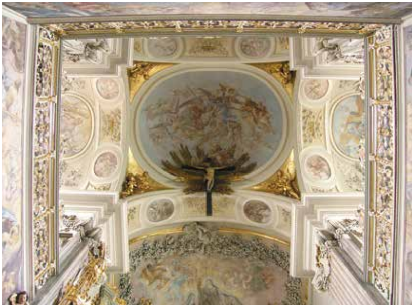
41.7. Sklepienie przęśła krzyżowego
