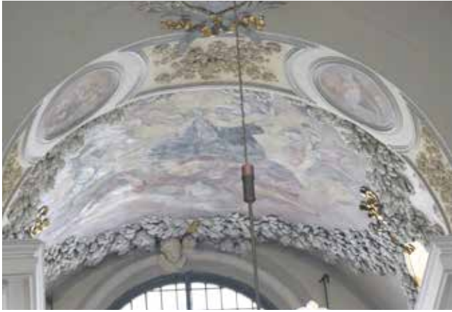
41.5. Sklepienie empyry między wieżami
