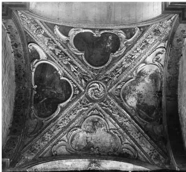
23.7. Kaplica św. Ignacego, sklepienie, stan z r. 1922
