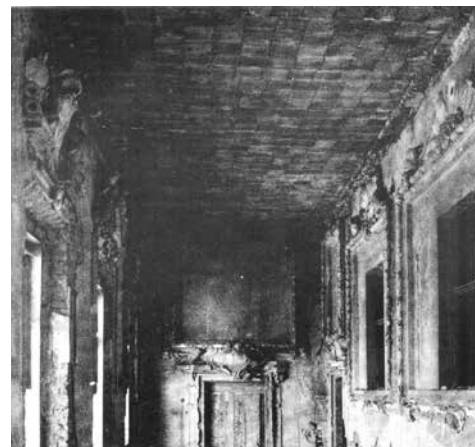
2.1.1 Galeria, wnętrze od pd. zach., stan przed r. 1956
