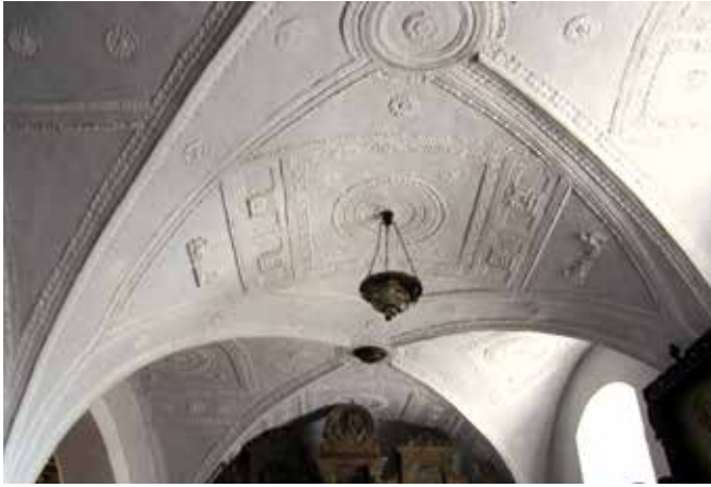
157. Gryfów Śląski, kaplica Schaffgotschów przy kościele par., sklepienie
