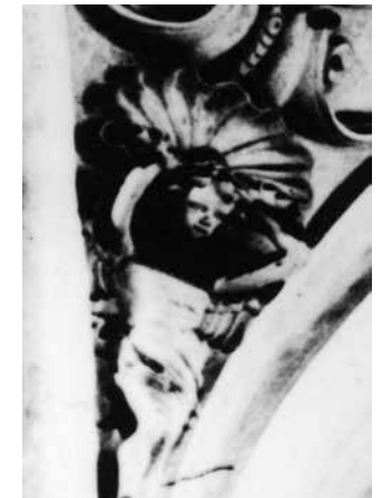
63.4. Sklepienie przęsła krzyżowego, fragment, stan z r. 1918
