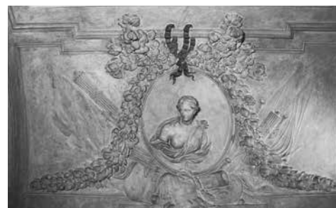
46.4. Wnętrze w trakcie tylnym, fragment dekoracji
