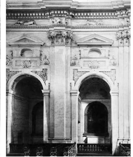
63.2. Ściana nawy, stan z w. XIX
