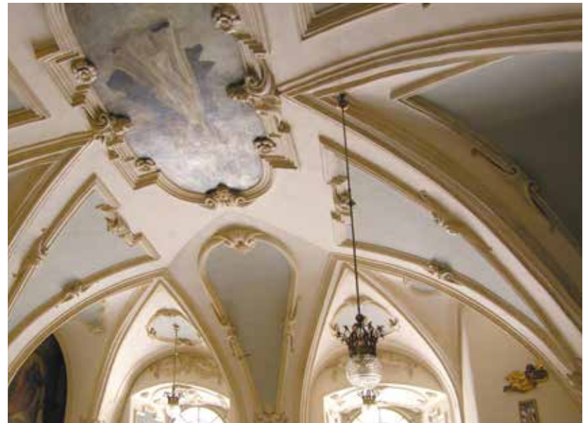
155. Kraków, kościół Dominikanów, sklepienie zakrystii
