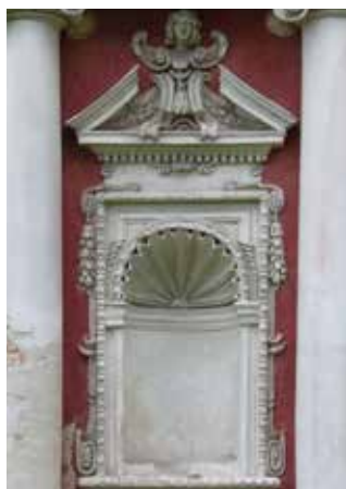
7.8. Nisza w elewacji pd.
