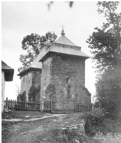
Il. 3. Cerkiew św. Onufrego, widok od strony zachodniej na wieżę
