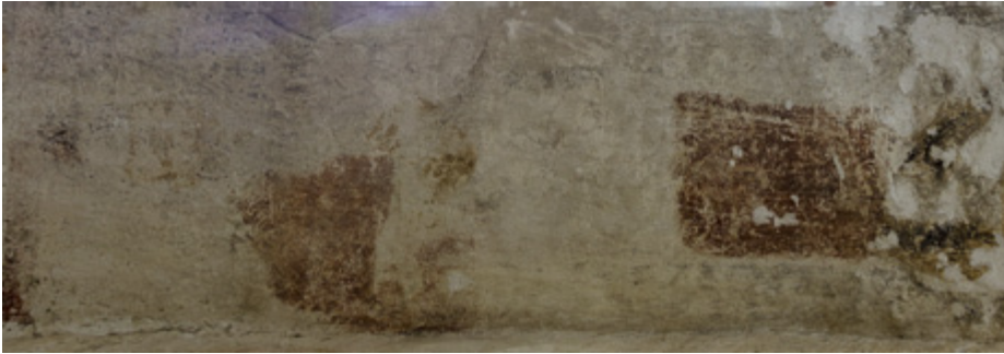
II. 105. Prorok Izajasz na ścianie południowej nawy
