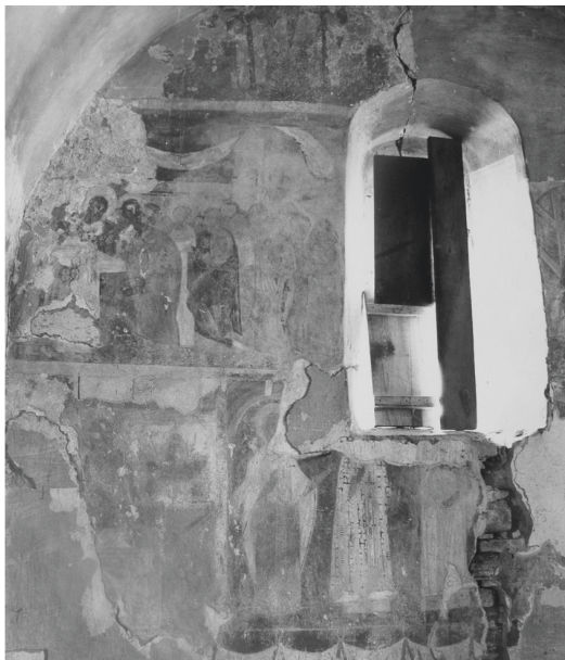
Il. 16. Ściana wschodnia sanktuarium, okno przed przywróceniem pierwotnych rozmiarów
