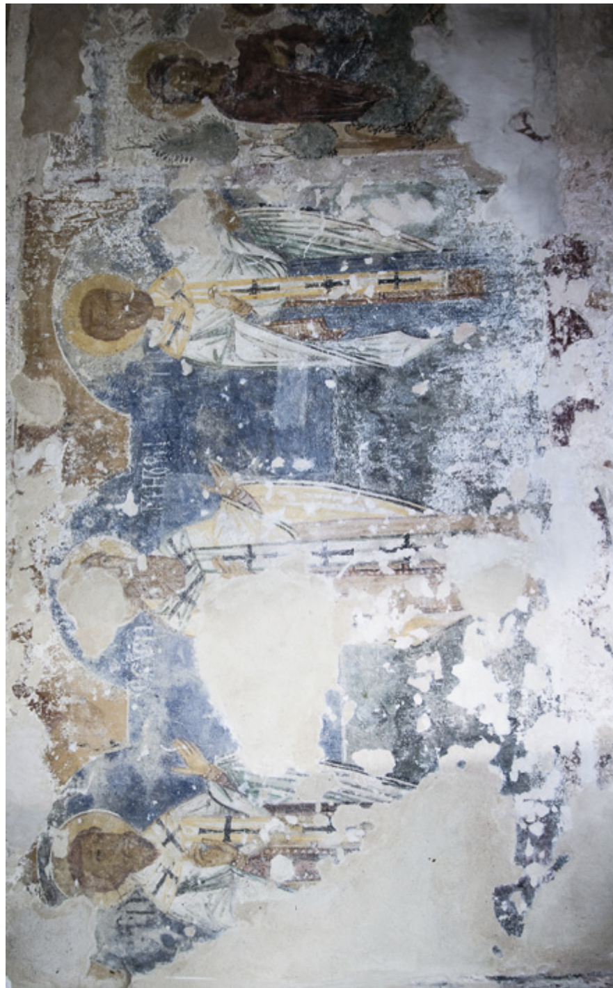
Il. 37. Fragment Orszaku biskupów, na ścianie północnej sanktuarium
