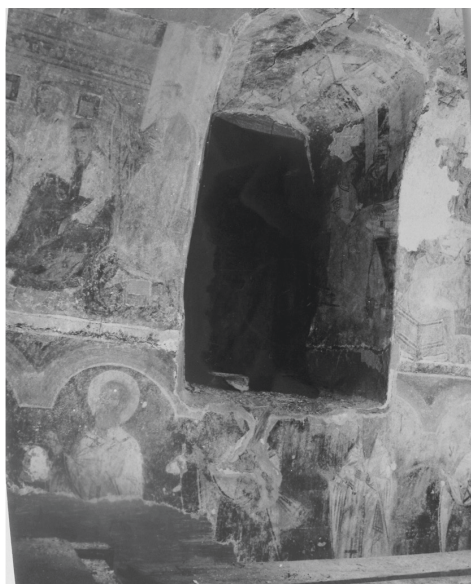
Il. 17. Ściana południowa sanktuarium, okno przed przywróceniem pierwotnych rozmiarów
