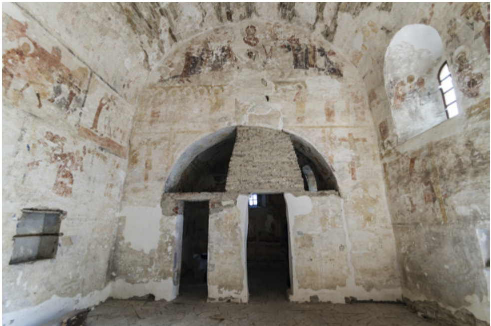
Il. 76. Malowidła na ścianie wschodniej nawy
