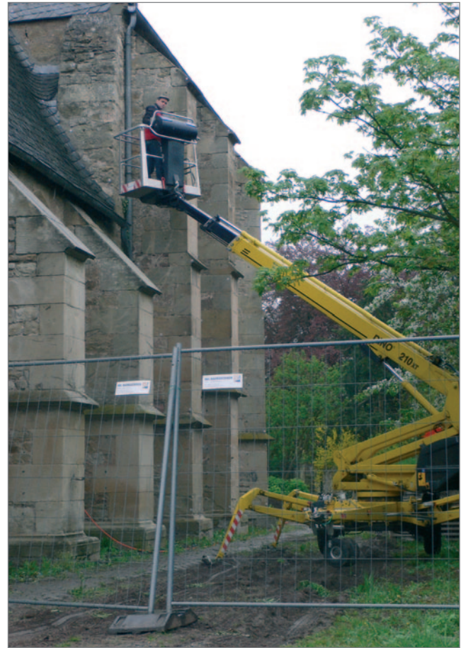
Abb. 6: Hilfsmittel Arbeitsbühne: Anbringung von Messmarken am Mauerwerk und anschließende annähernd frontale fotografische Erfassung mit einer Messkammer (Klaus Trumpke 2013).
