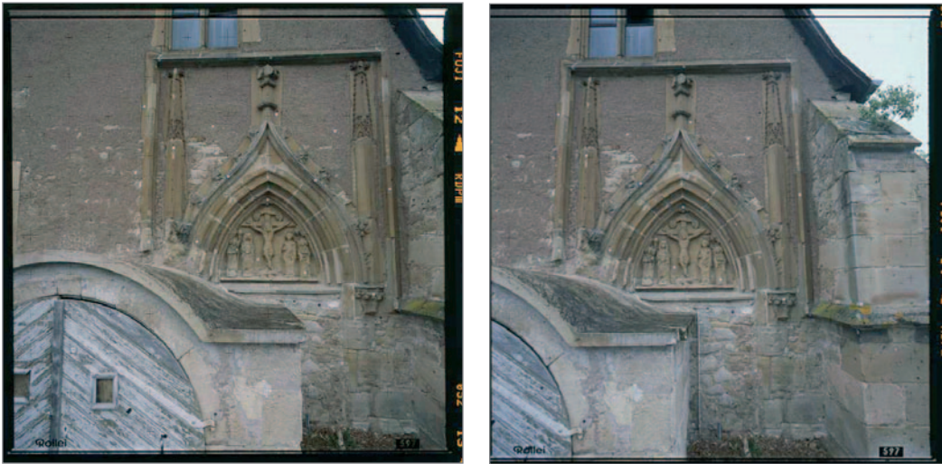
Abb. 13 a/b: Stereoskopisches Bildpaar des Portals mit verschobenem Aufnahmestandort bei paralleler Bild- achse (Messkammer Rollei metric 6006, Klaus Trumpke 2013).
