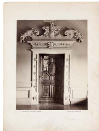
15. Baranów Sandomierski, zamek, portal komnaty na piętrze w trakcie wsch. Fot. I. Krieger, 1898–1901
