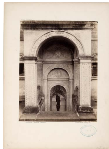
217. Gołuchów, zamek, portal i schody do suterren.
