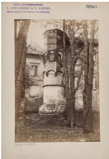
133. Dębno Brzeskie, zamek, baszta w elewacji zach.
