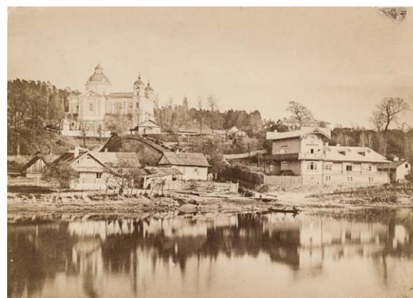
1618. Wilno, kościół św. Piotra i Pawła na Antokolu. Fot. J. Czechowicz, ok. 1874
