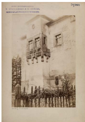
134. Dębno Brzeskie, zamek, wykusz w elewacji pn.
