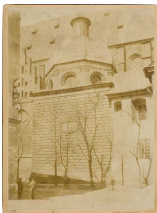
813. Kraków, kościół Dominikanów pw. św. Trójcy, kaplica Myszkowskich, widok z zewnątrz.
