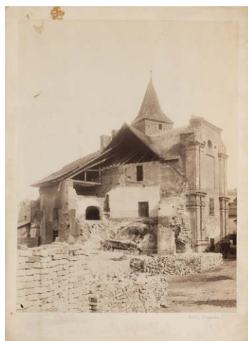
727. Kraków, kościół św. Ducha podczas rozbiórki. Fot. I. Krieger, 1890-1892
