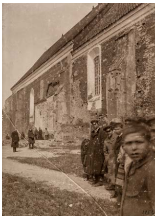
147. Gąbin, kościół parafialny, elewacja boczna. Fot. J.P. Dziekoński, 1896
