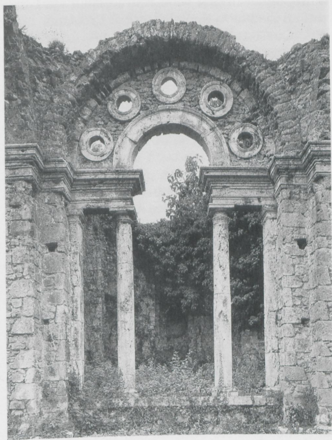
13. Roma, Arco di Tito: imposta (da Desgodetz) ■ 14. Genazzano, «Ninfeo»: trabeazione interna con trabeazione abbreviata.
