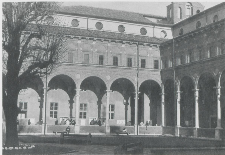
4. Milano, S. Ambrogio: chiostro ionico.
