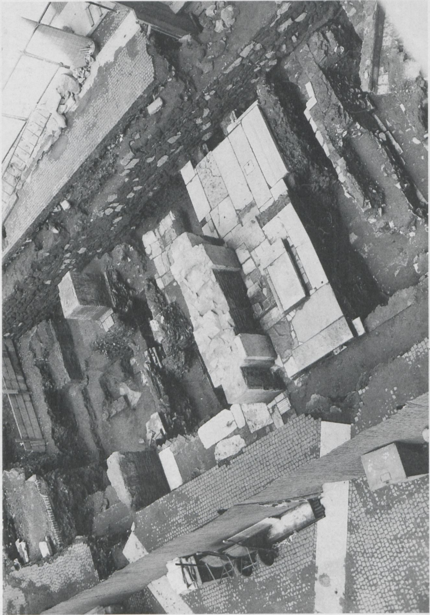
Abb. 6 Rom, Alt-S. Lorenzo in Damaso. Blick von Nordosten mit Resten des damasianischen Fußbodens im Mittelschiff
