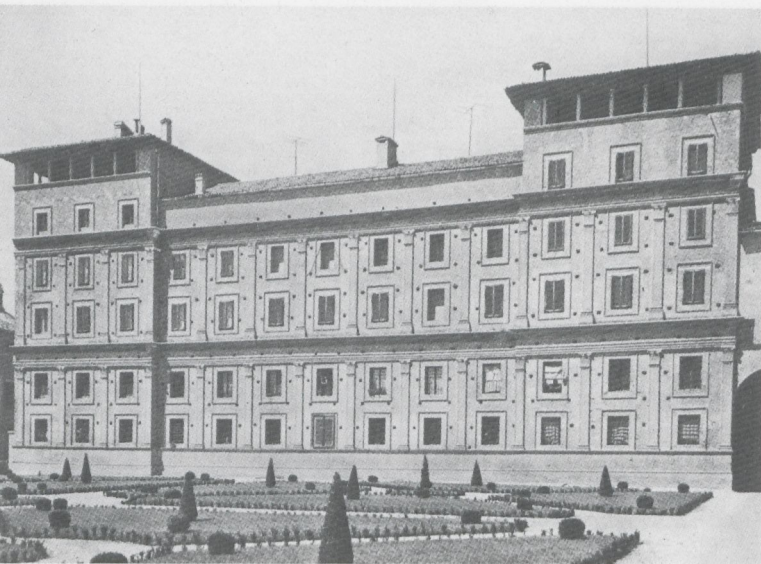
11 - Mantova, Domus Nova, facciata.
