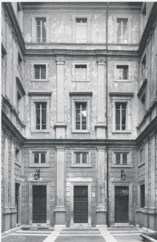
Roma, palazzo Stati Maccarani, esterno. Roma, palazzo Stati Maccarani, cortile, parete posteriore. Roma, palazzo Stati Maccarani, cortile parete destra.
