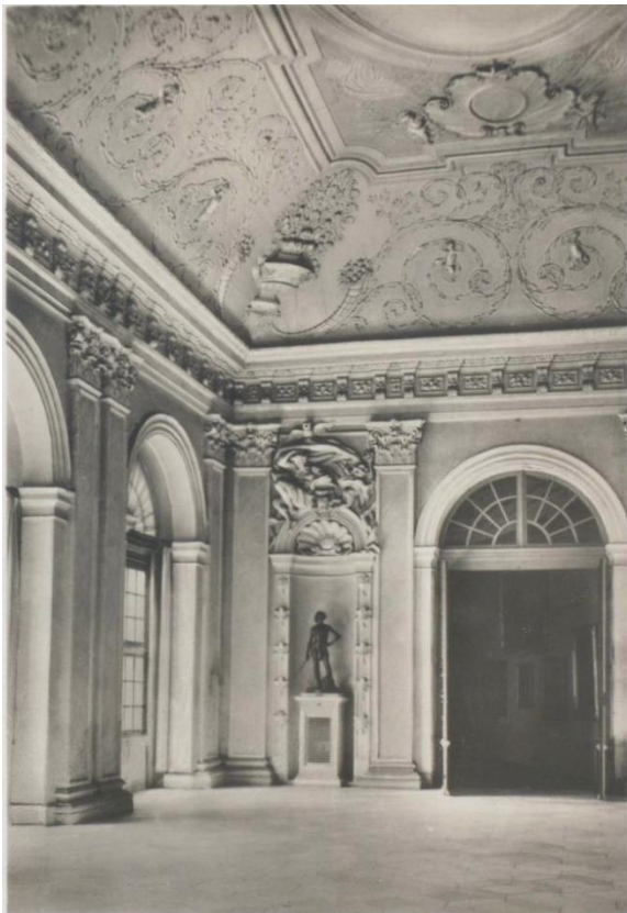
Abb. 2.8: Wassersaal der Orangerie [Blick von Osten nach Westen], ca. 1925, Fotopostkarte; aus: Heimat- und Geschichtsverein Erlangen, Postkartensammlung zur Orangerie; URL: orangerie.wisski.data.fau.de/wisski/navigate/1004/view .
