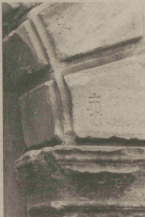
DIE STEINMETZZEICHEN von Vogt und Völkhle an Polsterquadern der Torbogen.
