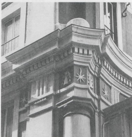
Fig. 17. Roma, palazzo Zuccari. Facciata principale, trabeazione del pianterreno.
