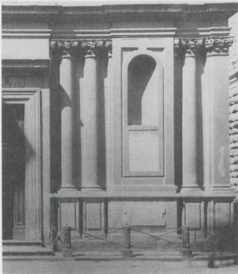
Fig. 13. Firenze, S. Giovannino. Particolare della facciata.
