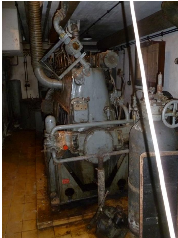
Abb. 90: Kavalierhaus, Luftschutzbunker: U-Boot Motor, Zustand 2016
