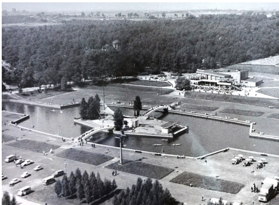
Il. 39. Kanał II z Wyspą pod Żaglami, 1969. BGPW, sygn. FT 001976.
