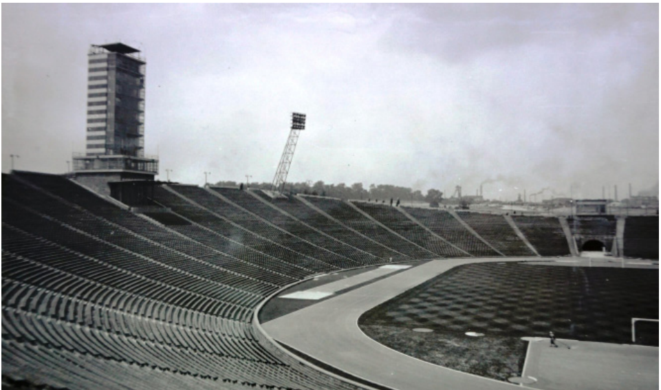
Il. 31. Stadion Śląski z wieżą dyspozytorską. BGPW, sygn. FT 002111.
