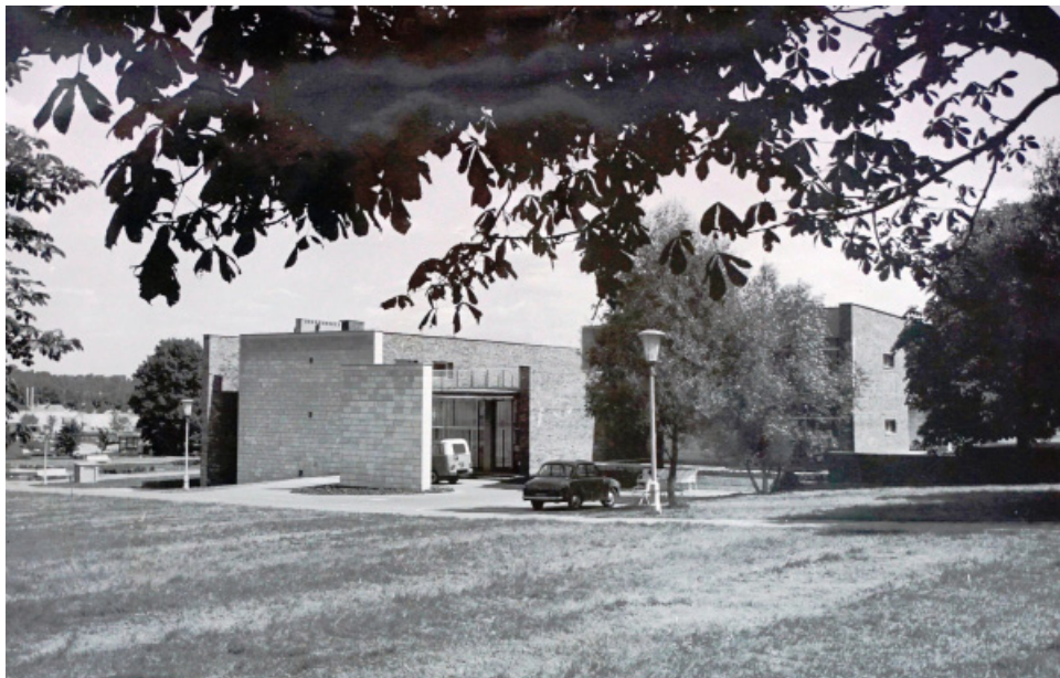
Il. 125. Budynek administracyjno-recepcyjny. BGPW, sygn. FT 2153.
