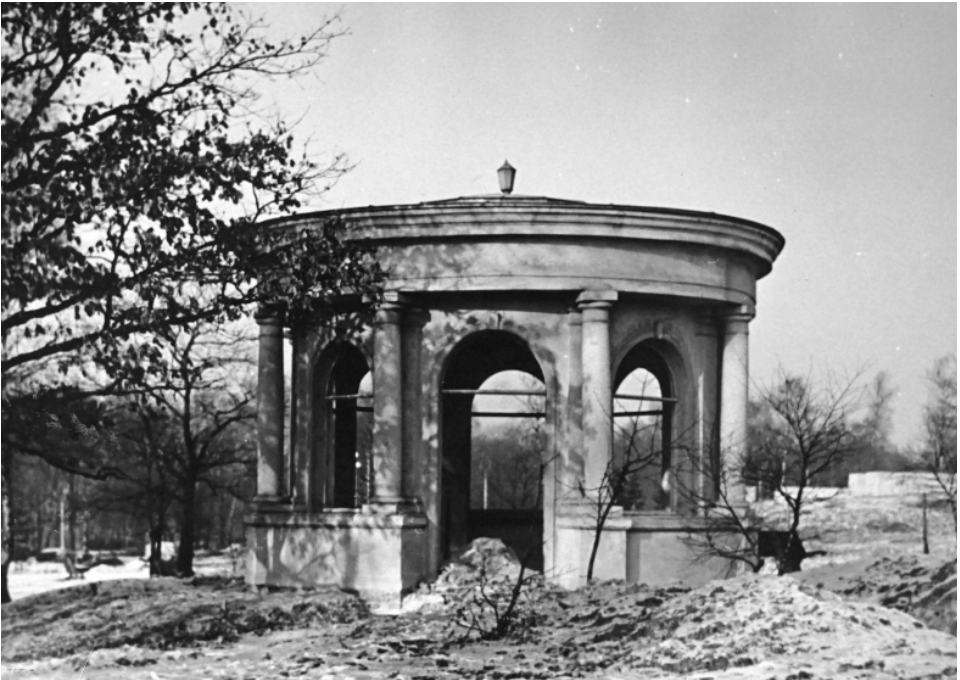
II. 42. Kiosk spożywczy w budowie. APK, zesp. 480, sygn. 2/17.
