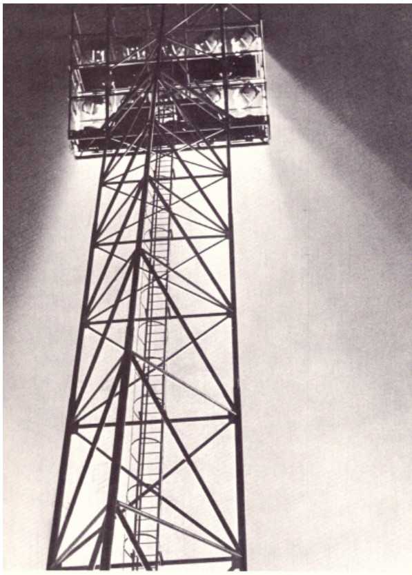
Il. 34. Maszt oświetleniowy, fot. Bogdan Krasicki. Śląski Park Kultury... , wyd. 2, s. 164.
