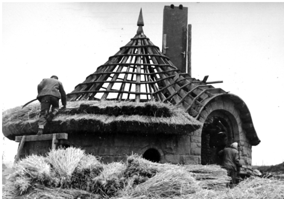
Il. 58. Budowa domku dla łabędzi, 1954. APK, zesp. 480, sygn. 2/17.
