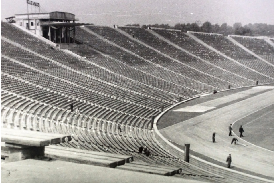
Il. 30. Fotografia Stadionu Śląskiego, ok. 1959 r. APK, zesp. 2753, sygn. 385.
