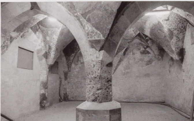
Abb. 21: Graz, Stadtbürg, Gratgewölbe der Erdgeschosshalle (sog. Einstützenhalle), Datierung unklar, sicher vor 1493, Bemalung modern
