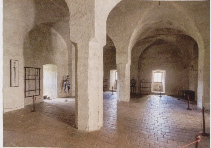
Abb. 20: Schwihau (Svihov), Wasserburg, mit romanisierenden Gratgewölben gewölbter Saal im ersten Obergeschoss des Südflügels der Kernburg, errichtet zwischen 1480–1489 (inschr.)
