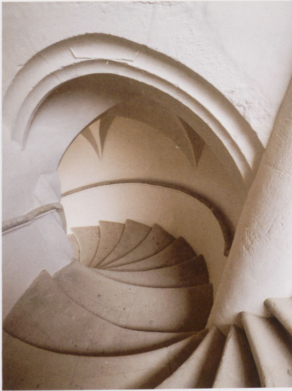
Abb. 29: Wittenberg, Schloss, südliche Treppenanlage, Aufgang zum zweiten Obergeschoss, Zustand 2018 nach der jüngsten Sanierung
