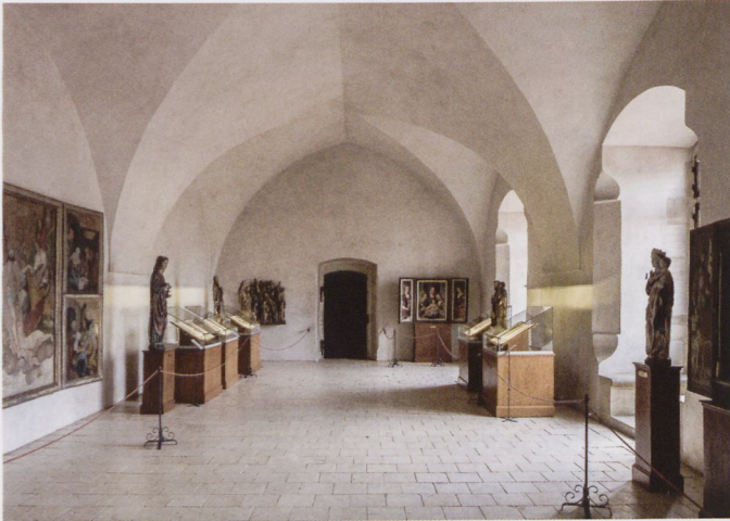
Abb. 19: Pürglitz (Krivoklat), ehem. königliche Burg, mit romanisierenden Gratgewölben gewölbter Saal im ersten Obergeschoss des Südflügels der Kernburg, um 1470/80?
