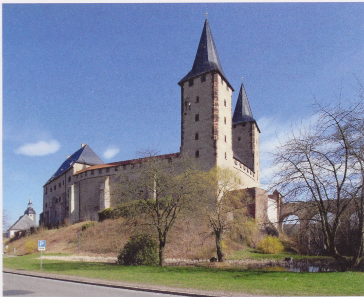
Abb. 5: Schloss Rochlitz, Blick auf die beiden um 1383/1395 erbauten Wohntürme (Juppen) und den etwa zeitgleichen Palas mit dem Stubenappartement (links).
