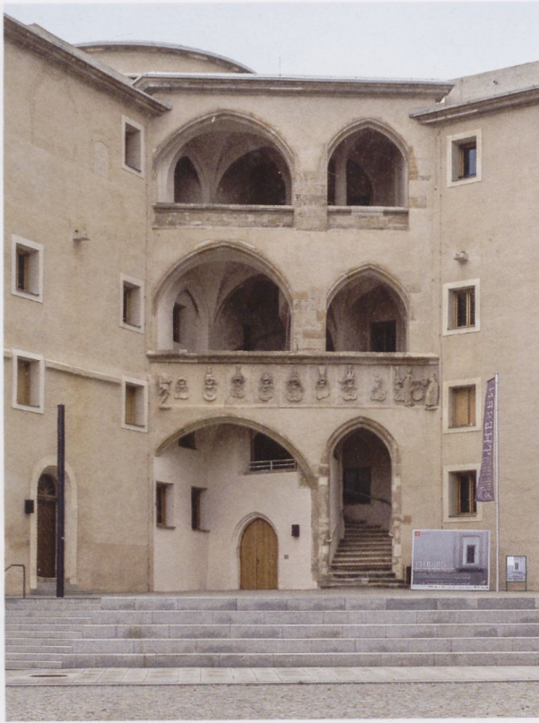
Abb. 26: Wittenberg, Schloss, südliche Treppenanlage, Zustand 2018 nach der jüngsten Sanierung
