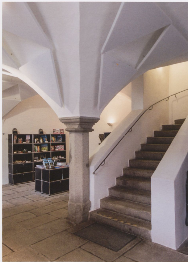
Abb. 10 Burg Schwihau (Švihov) des Obersten Richters Botho (PDta) Schwihau von Riesenberg, Treppenanlage mit romanisierenden Grat- und Tonnengewölben als Beispiel der frühen Renaissanceromanik, 1480/1489
