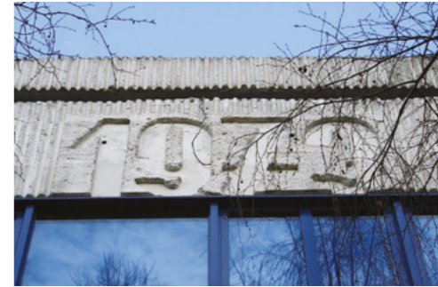
Fig. 77 Decorative detail on the bank building in Niepodległości Ave., design by Marek Dziekoński
