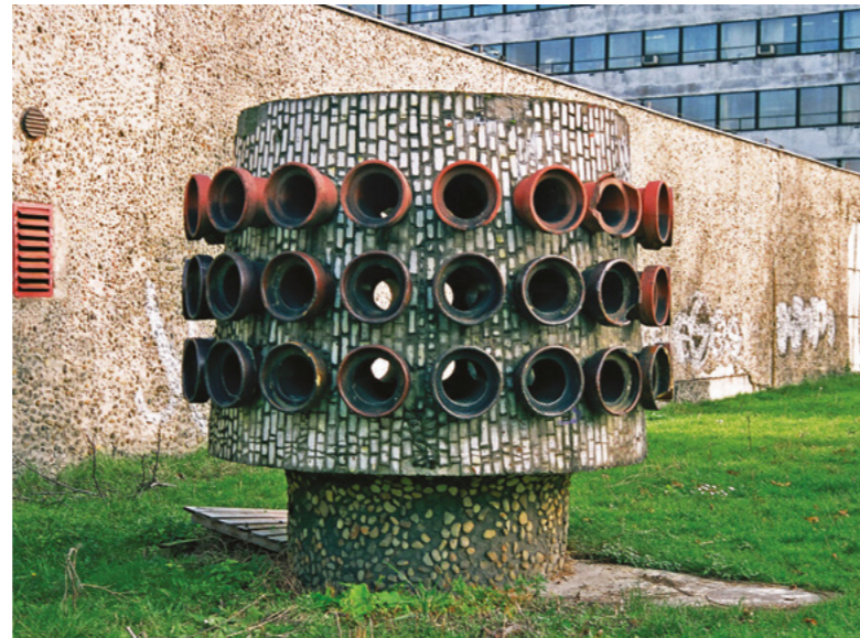
Fig. 75 Non-surviving air conditioning intake at Tychy's Mining Electronics Company (Zakład Elektroniki Górniczej – ZEG), design by Marek Dziekoński, c. 1970
