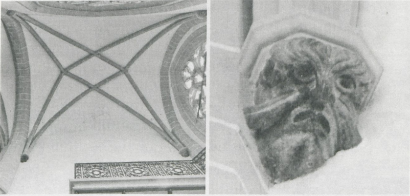
Abb. 1: Peterskirche Görlitz, Westjoch im Nordaußenschiff mit Knickrippensterngewölbe über vier Konsolen. Abb. 2: Peterskirche Görlitz, Konsole im Westjoch mit Teufelsmaske
