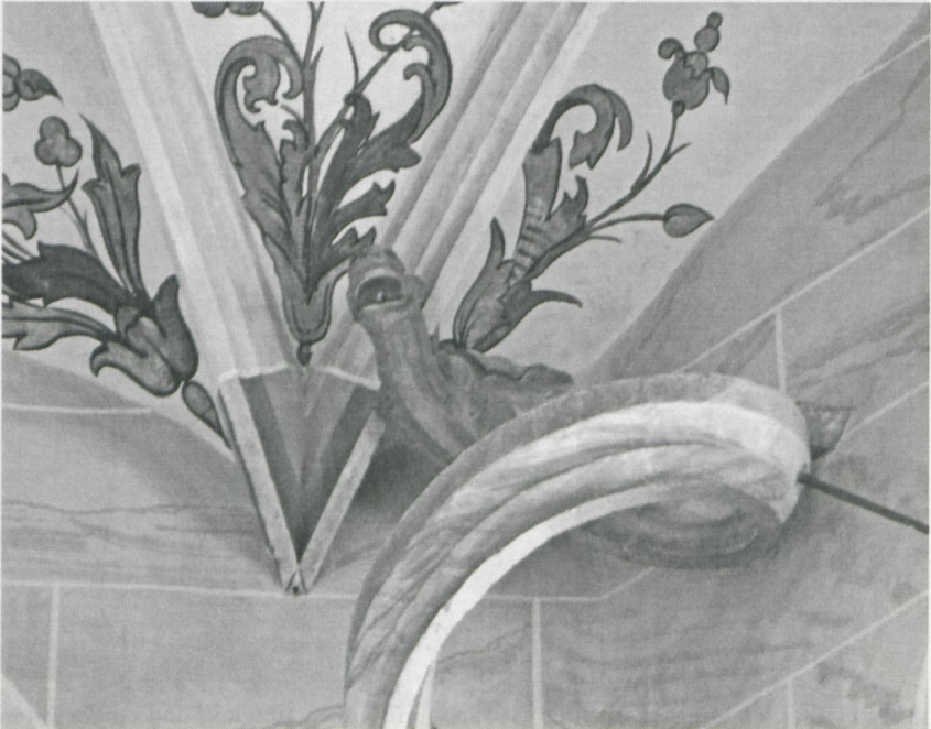
Abb. 13: St. Marien Zwickau, Drachenkopf am oberen Ende der sogenannten Hobelspanrippe
