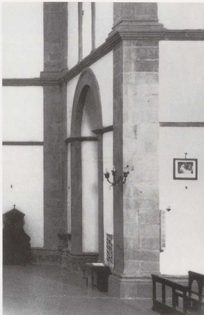
9. Cortona, Madonna del Calcinaio, interno, particolare
