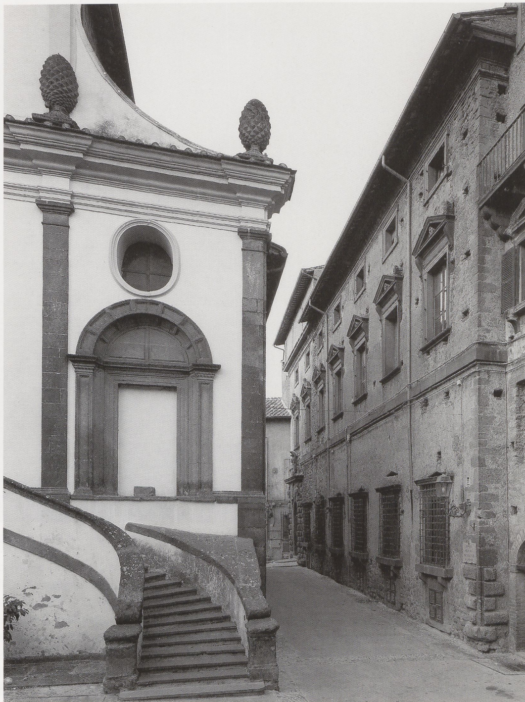
3. Bomarzo, Palazzo Orsini con Chiesa di Santa Maria, visto da nordest
