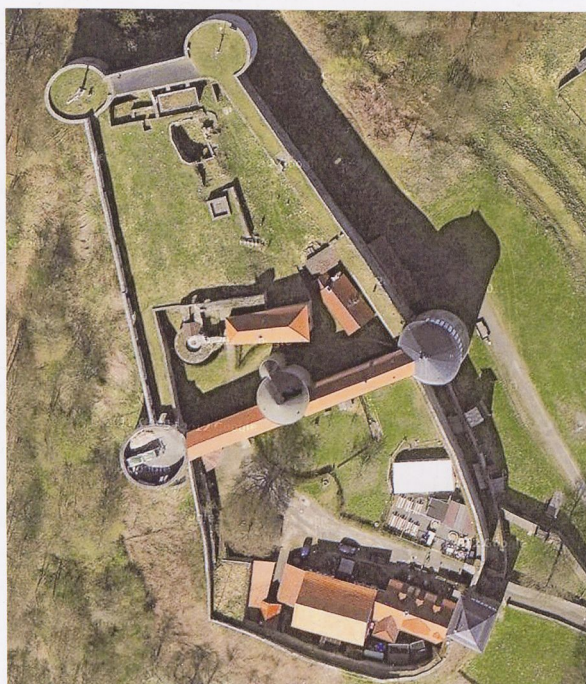
Abb. 13 Burg Herzberg (Hessen, Lkr. Hersfeld-Rotenburg, Gem. Breitenbach am Herzberg), Luftaufnahme. Die aus dem späten 13. Jh. stammende Burg wurde 1480-97 von Hans-Jakob von Ettlingen durchgreifend modernisiert. Aus dieser Zeit stammen alle Rondelle, unter denen vor allem jenes interessant ist, das wie ein Bergfried in die Mitte der Angriffsseite gesetzt wurde. Mauerwerk, Kanonenscharten und Treppenturm belegen die Datierung eindeutig.
