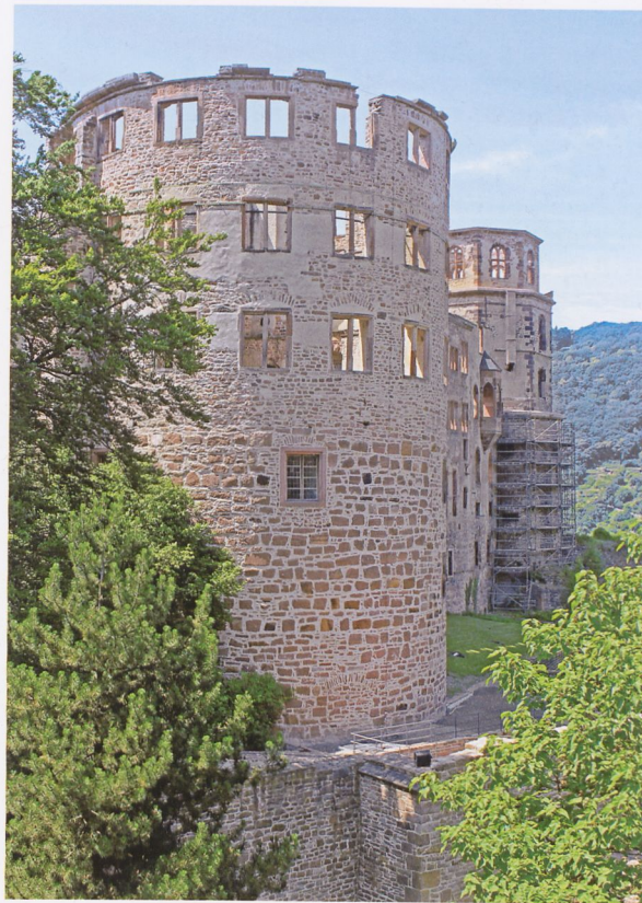
Abb. 14 Heidelberg, Schloss, der „Apotheker-“ und der „Glockenturm“ von Süden. Der Unterbau eines der beiden Türme oder des hier nicht dargestellten „Krautturms“ an der Ostseite des Schlosses dürfte 1488 als begonnener Turmbau bzw. als Rondell erwähnt worden sein. Die Oberbauten sind in allen Fällen deutlich jünger. (Foto Verf.)
