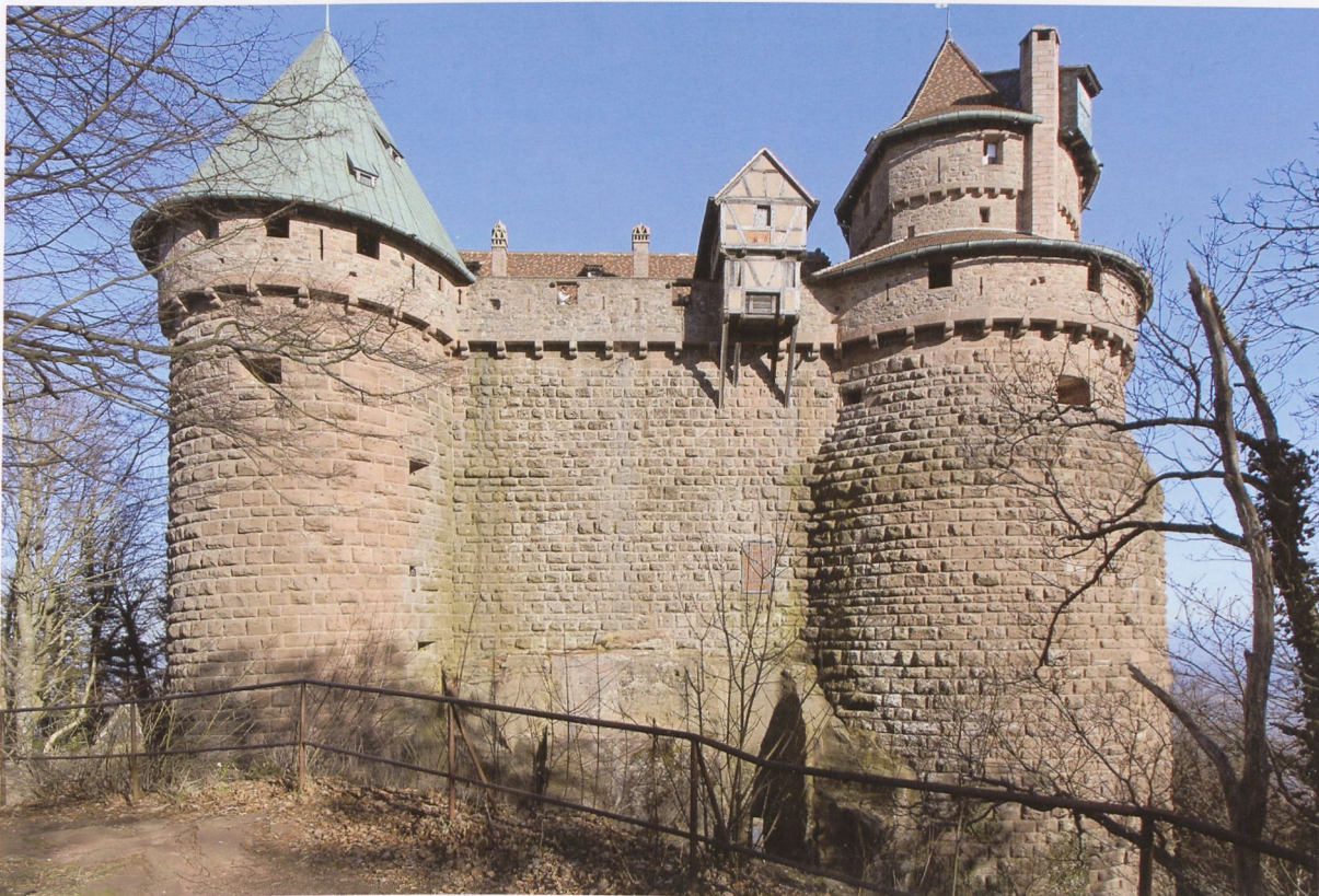
Abb. 15 Hohkönigsburg (Unterelsass, bei Orschwiller), das „Große Bollwerk“ von Westen. Der äußerst massive Bau mit zwei Rondellen entstand in der 1479 begonnenen Wiederaufbauphase der Burg und sollte ihre einzige Angriffsseite decken.
