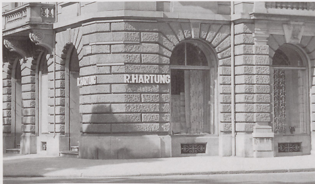
Atelier für individuellen Innenausbau von Robert Hartung im Parterre des Gebäudes in der Fraumünsterstrasse 2/ Stadthausquai 1 in Zürich, Ausschnitt, Fotografie, 1947, Baugeschichtliches Archiv der Stadt Zürich.
