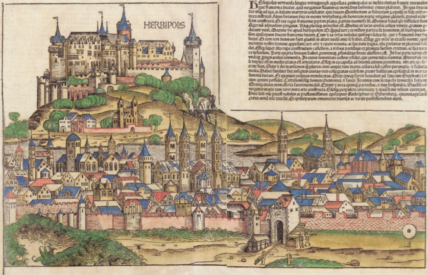
Abb. 3: Befestigtes Schloss auf dem Marienberg, fortifikatorischer Stand mit Mauern, Zinnen und hölzernen Wehrgängen; Zustand vor der wehrbautechnischen Reaktion auf Pulverwaffen, kolorierter Holzschnitt (Abb. entnommen aus: Weltchronik des Hartmann Schedel, Nürnberg 1493).
