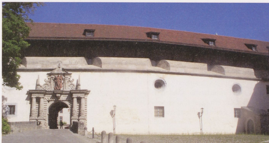
Abb. 9: Blick auf die hoch aufragende Kurtine als Schildmauer der Echterbastei mit gerundeter Brustwehr und später aufgerichteten Überdachung (Foto: Stefan Bürger).
