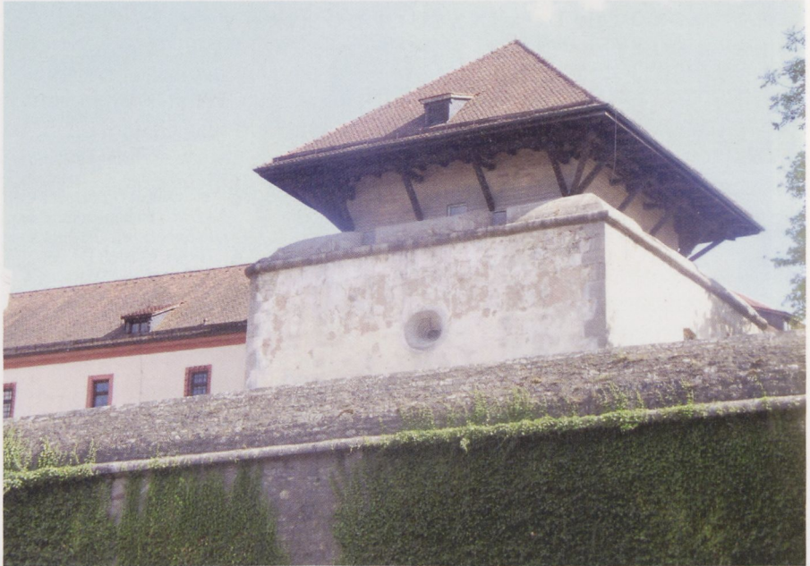
Abb. 11: Turmartiges, nördliches Eckbollwerk mit Brustwehr und Geschützscharten; davor: Brustwehr mit Kordonsims der späteren bastionierten Umwallung (Foto: Stefan Bürger).
