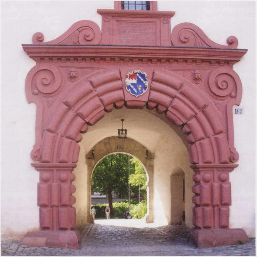
Abb. 14: Durchblick durch die Toranlage der Echterbastei vom Innenhof; diamantierter Portalbogen mit ohrenartigen Voluten; auf der Rückseite des Außentores sind die Anschläge und Lagerungen für die ehemaligen Torflügel erhalten (Foto: Stefan Bürger).
