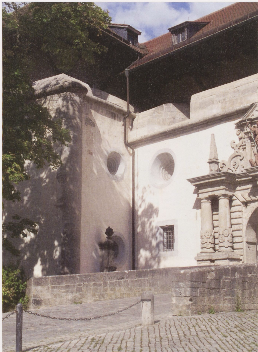
Abb. 12: Blick auf die mehrgeschossige kasemattierte Flanke; die Stellungen der Geschütze liegen feldseitig gedeckt hinter leicht ausgezogenen und gerundeten Flügeln (Orillons); womöglich war dieser Schutzeffekt gering und die Form eher von symbolischem Wert (Foto: Stefan Bürger).
