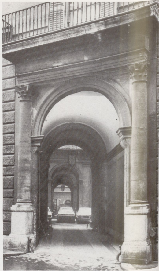
Fig. 6, Palazzo Balami-Galitzin, porta della facciata orientale
