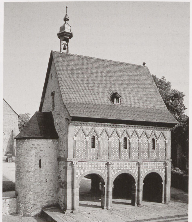
14 Sog. Torhalle, Ansicht von Westen
