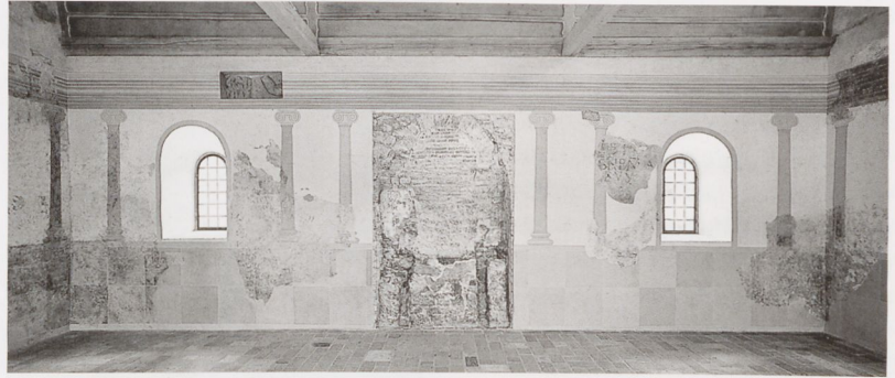
15 Sog. Torhalle, Ansicht des Obergeschosses nach Osten mit gemalter Wandgliederung
