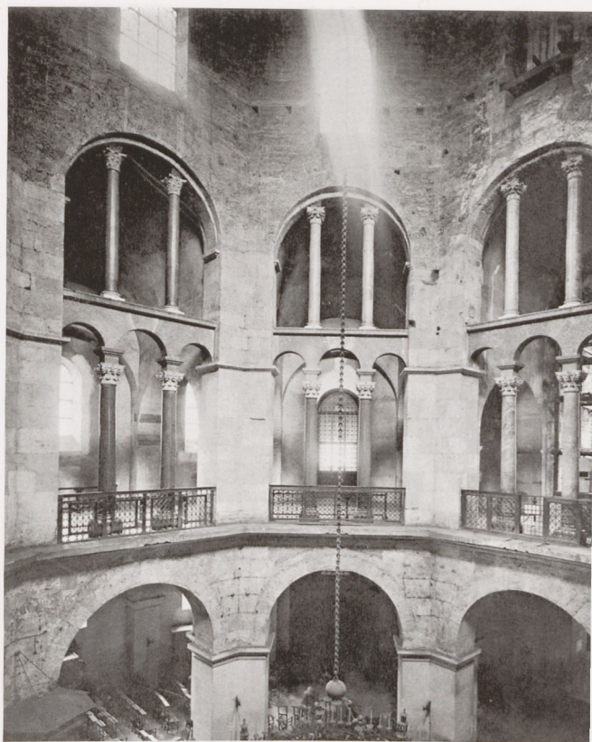
4 Aachen, südwestliches Oktogon des Doms, ehem. Pfalzkapelle, historische Aufnahme vor 1913
