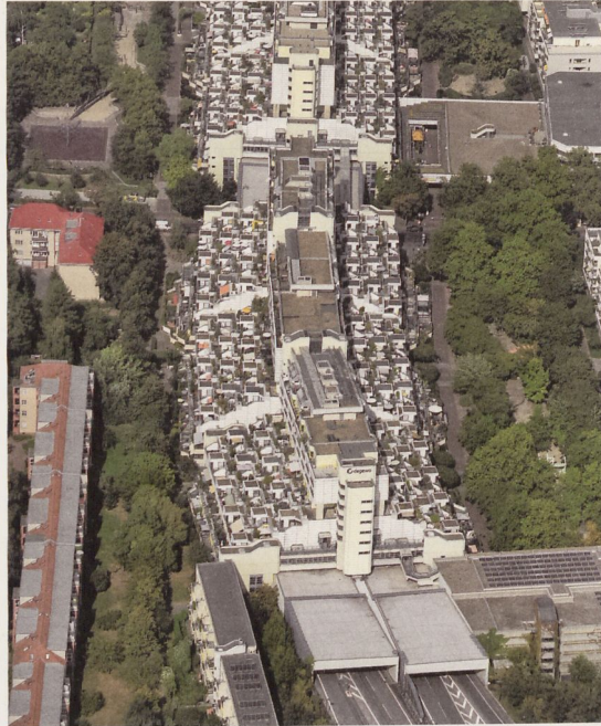
5 Georg Heinrichs: Autobahnüberbauung Schlangenhader Straße, Berlin, 1967 E , 1971 B –1981 Foto: Robert Grahn, 2016
