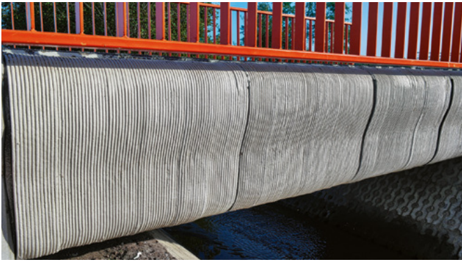
Abb. 2: Detail einer 3D-gedruckten Brücke über einen Kanal in Gemert, Niederlande (Foto: Marczoutendijk, CC BY-SA 4.0).
