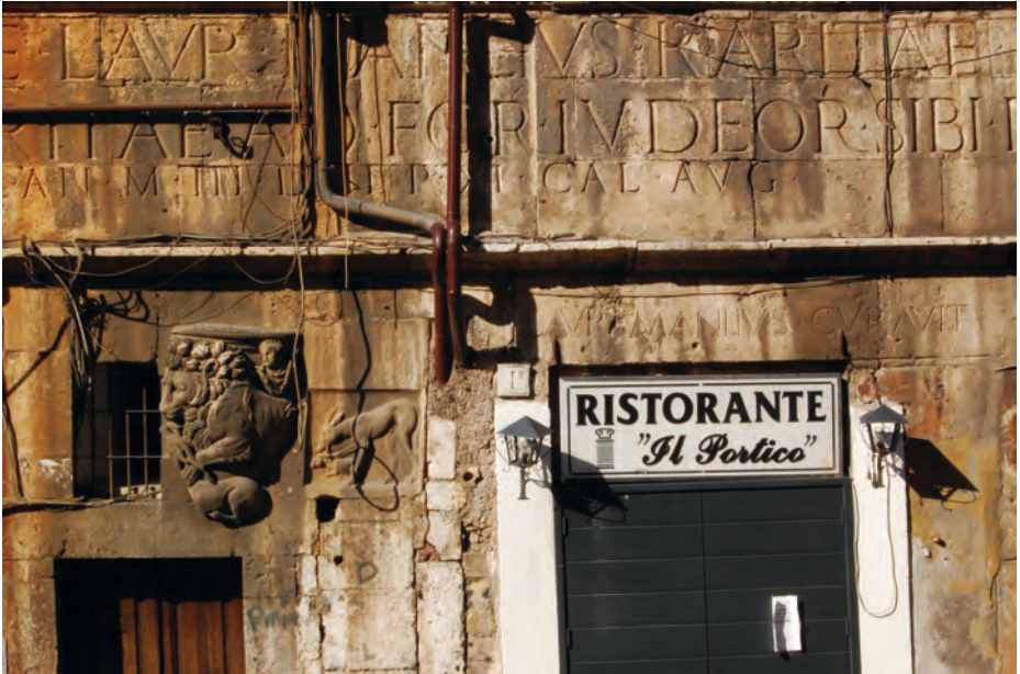
Abb. 5: Detail der Fassade mit Bauinschrift, Fragment eines römischen Sarkophags und griechischer Grabstele, Rom, «Casa Manlio» (Photo: Verfasserin)
