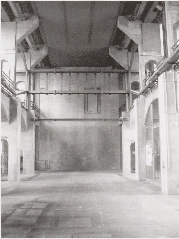
Abb. 1: Schlosskapelle Dresden, Rohbausituation vor 2009
