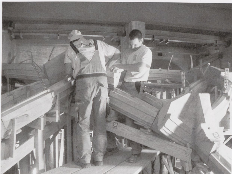
Abb. 7: Schlosskapelle Dresden, Versetzen eines Rippenstücks, 2011
