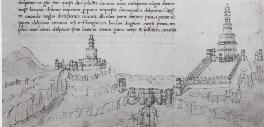
Abb. 6 Brücke über den Indo, Cod. Magl. II. I. 140, fol. 97r
