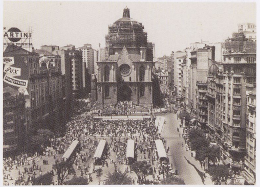
Ill. 14. São Paulo, Brésil, Catedral Metropolitana (Maximilian Hehl, 1913-2002). Consécration à l'occasion du 400 e anniversaire de São Paulo en 1954; les tours de façade ont été grossièrement achevées en 1967, leur extension selon le plan initial a été réalisée de 2000 à 2002. © Werner Haberkorn (domaine public)
