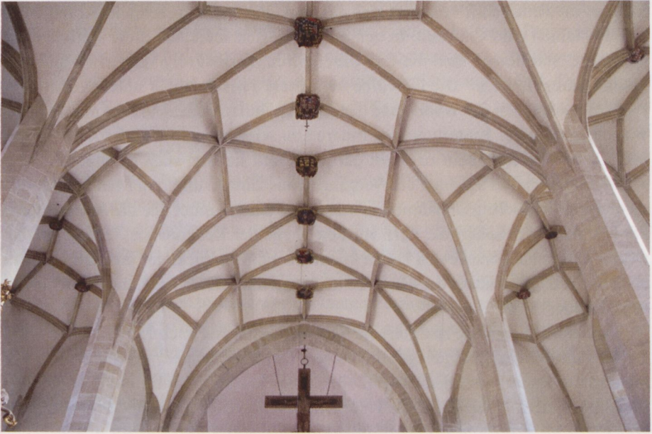
Abb. 1: Dom Merseburg, regelmäßiges netzförmiges Langhausgewölbe
