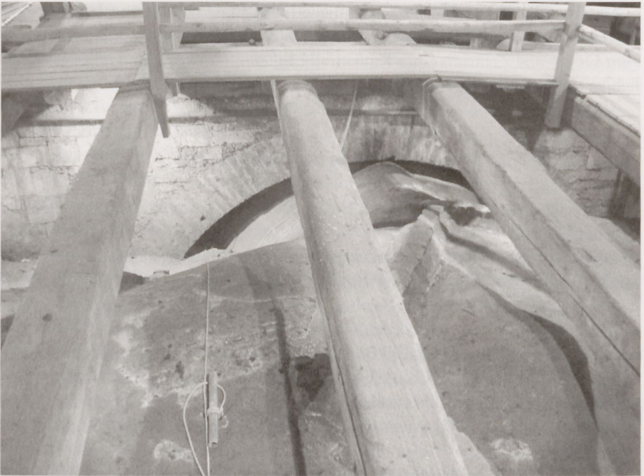
Abb. 9: Scheidbögen mit Sargmauern im Dachraum mit darunter hindurchgezogenen Wölbungen
