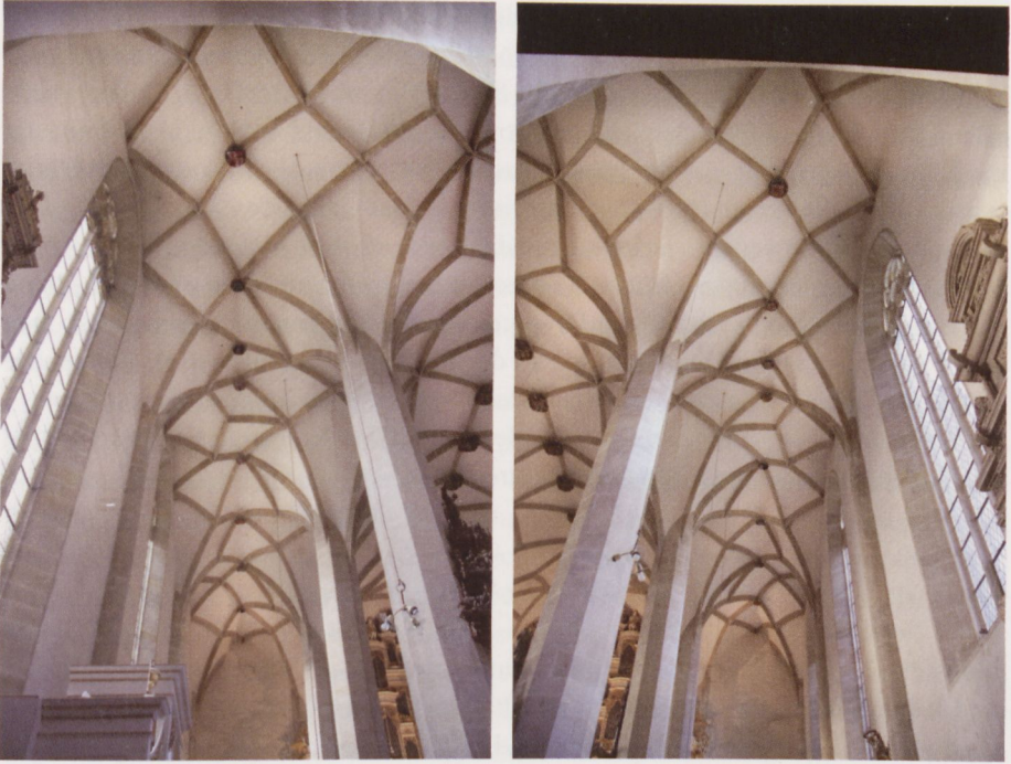
Abb. 2 und 3: Dom Merseburg, unregelmäßige Seitenschiffgewölbe mit wechselnden Höhen der Auflager, schwer durchschaubaren Rippenverläufen und ungleichen Kappenformaten
