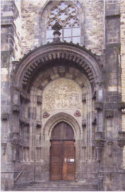
Abb. 22: Prag, Teynkirche, Nordportal, Zusammenschluss mehrerer Bogenfelder durch überhöhte Portalachse und Einbezug der Strebe Pfeiler
