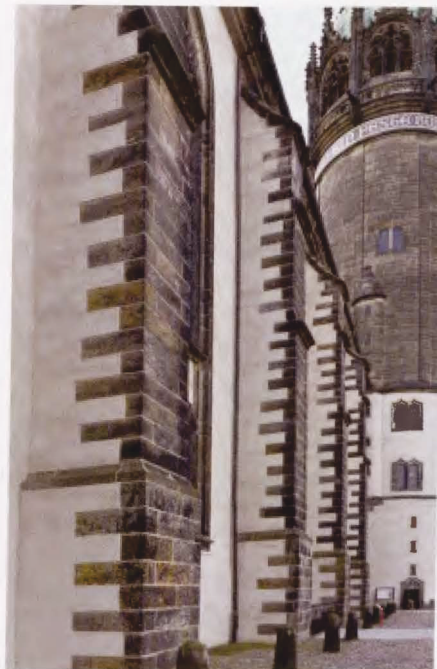
Abb. 10: Wittenberg, Schlosskirche, seitliche Ansicht der Strebe Pfeiler mit geschwungenen Verdachungen
