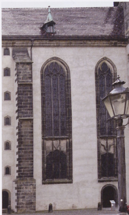
Abb. 12a, b: Wittenberg, Schlosskirche, Doppeljoch der westlichen Nordfassade; ursprünglich mit Giebel bekrönt, Fenster dort abweichend mit Vorhangbögen überfangen und dadurch ggf. ›stärker profan/schlosshaft‹ wirkend
