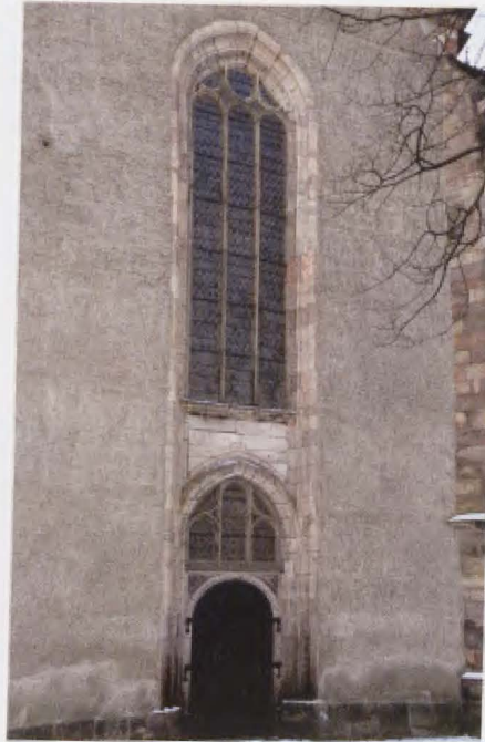
Abb. 26: Chemnitz, Schlosskirche, Nordquerhausportal, vereinfachte Fenster-Portalkombination
