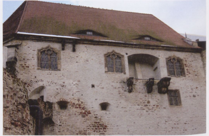
Abb. 41: Halle/Saale, Moritzburg, Blick auf die Nordfassade der Maria-Magdalenen-Kapelle mit Schießfenster und dem Verteidigungsgang auf das Eckbollwerk
