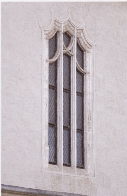
Abb. 17: Meißen, Albrechtsburg, Fenster mit Vorhangbogen und scherenförmiger Binnenfigur
