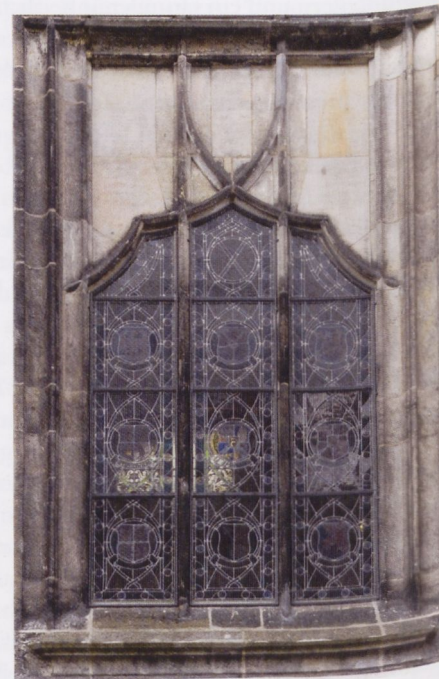
Abb. 16: Wittenberg, Schlosskirche, untere Fensteröffnung mit scherenartiger Durch- dringungsfigur, die sich zu einer Vorhang- bogenform zusammenfügt
