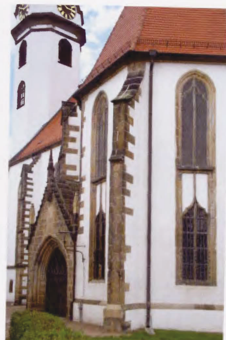
Abb. 11: Torgau, St. Marien, Strebe Pfeiler mit geschwungenen Verdachungen, Fenstergewände mit durchlaufendem Stabwerk, Vorhangformen und Bogenblende
