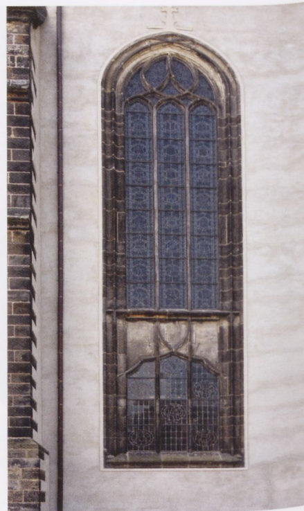
Abb. 13: Wittenberg, Schlosskirche, doppelzoni- ges Fenster der Nordfassade mit durchlaufendem Stabwerk, Vorhangbögen und Bogenblende
