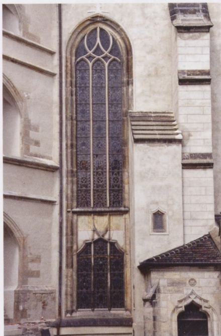
Abb. 14: Wittenberg, Schlosskirche, doppelzoni- ges Fenster der Hofseite mit durchlaufendem Stabwerk, Vorhangbögen und Bogenblende
