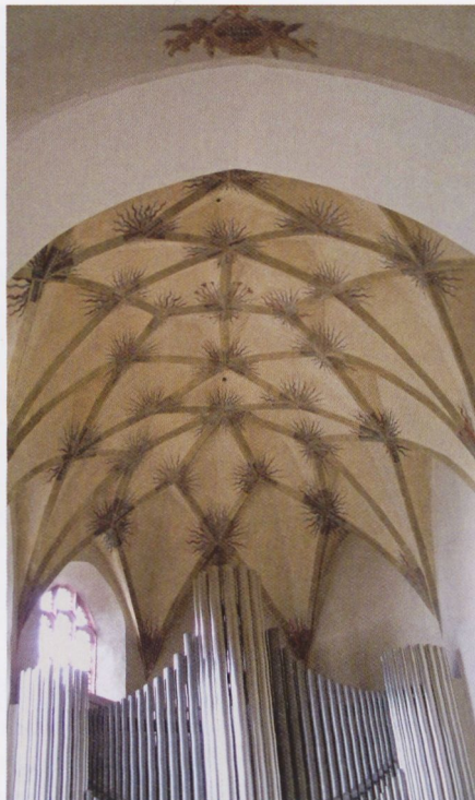
Abb. 32: Würzen, Dom, Gewölbe des Westchores, Gratzellengewölbe mit aufgemaltem Rippenwerk
