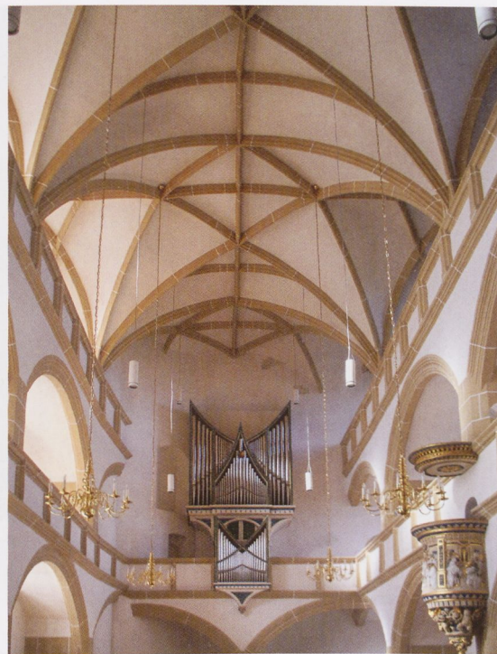
Abb. 35: Torgau, Schloss Hartenfels, Schlosskapelle, Innenraum mit umlaufenden Emporen über Segmentbögen und mit gefelderten Brüstungen
