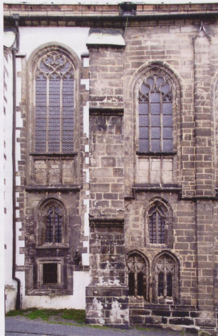
Abb. 15: Görlitz, Peterskirche, Südfassade, mehrzonige Fensteranordnung mit durch- laufendem Stabwerk in der oberen Brüstung und Vorhangbogenformen in den unteren Fenstern; die Blenden der Zwischendecke befinden sich hier in den Couronnements der unteren Sakristeifenster
