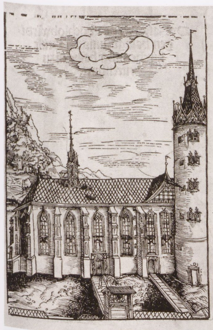
Abb. 37: Wittenberg, Schlosskirche, historische Ansicht der Nordfassade mit vorgelagertem Graben und Grabenübergängen, Heiltumsbuch, Lucas Cranach d. Ä., 1509
