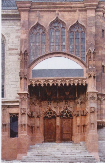
Abb. 23: Jena, Michaeliskirche, Südportal, sog. Brautportal, Fenster-Portalkombination unter Einbezug der Strebe Pfeiler
