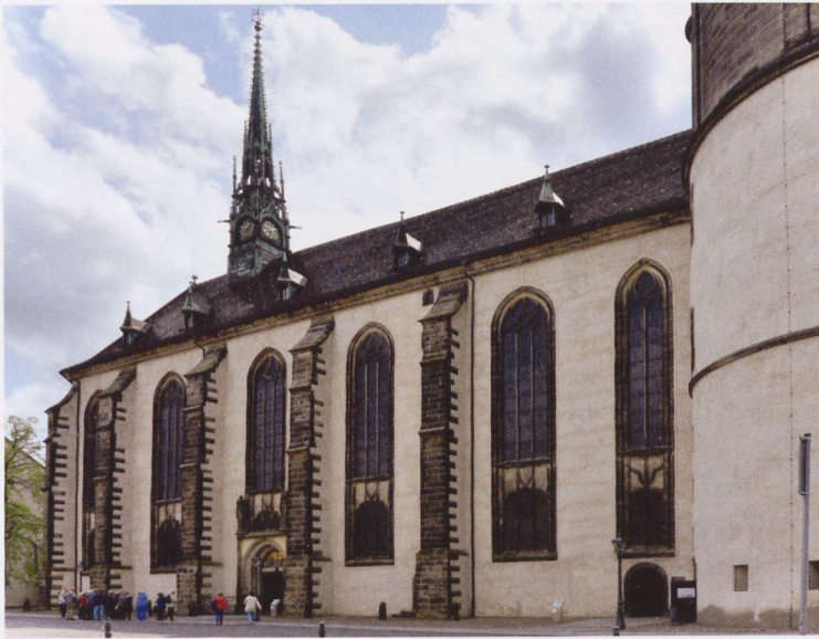
Abb. 7: Wittenberg, Schlosskirche, verputztes Bruchsteinmauerwerk der Nordfassade
