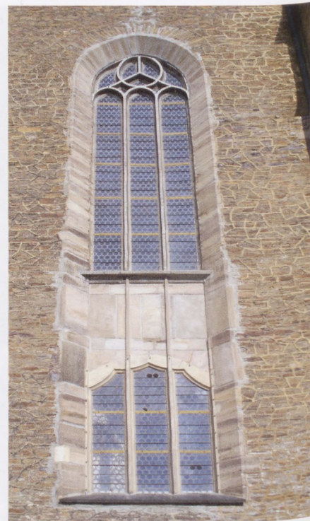
Abb. 33: Schneeberg, St. Wolfgang, Fensterachse mit durchlaufendem Stabwerk, vereinfachtem Vorhangbogen und glatter Bogenblende
