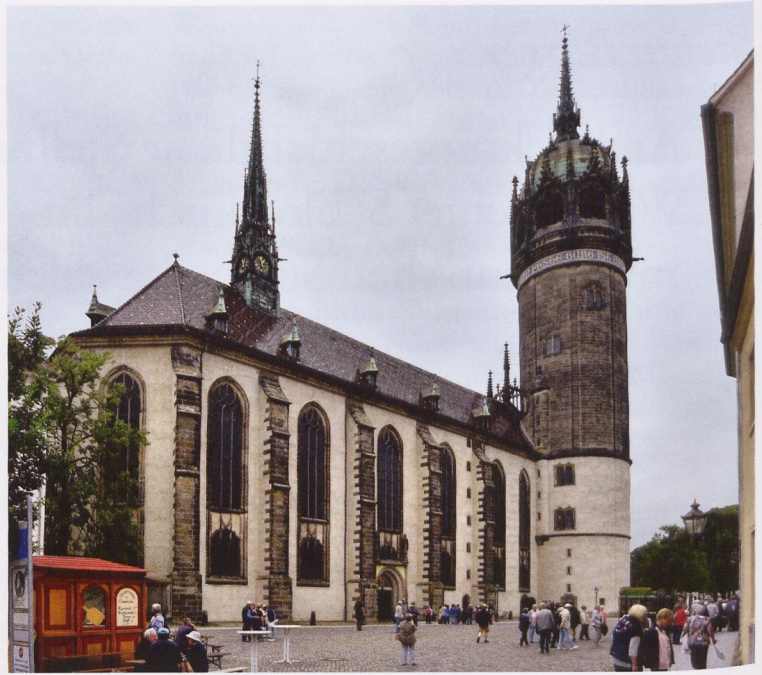
Abb. 2: Wittenberg, Schlosskirche, Blick auf die Nordfassade samt Nordwestturm
