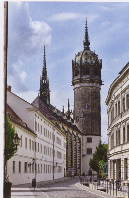
Abb. 39: Wittenberg, Straßenflucht mit Blick auf die Schlosskirche und den nordwestlichen Schlossturm
