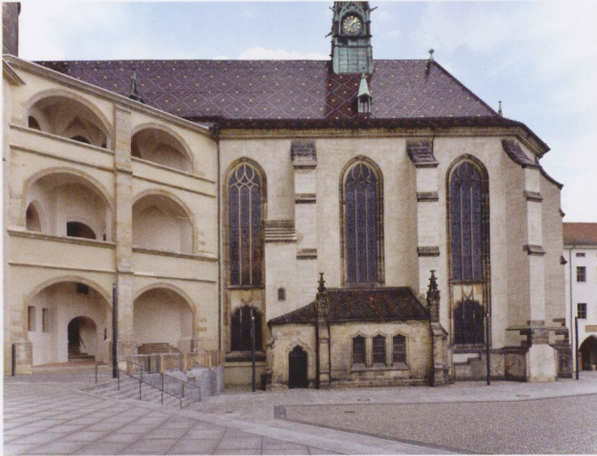
Abb. 46: Wittenberg, Schlosskirche, Südtreppenhaus und Südfassade
