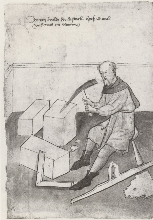
Abb. 3a: Steinmetz mit Spitzfläche, Hausbuch der Mendelschen Zwölfbrüderstiftung, Band 1, Nürnberg, 1426–1549, 28 × 19,5 cm, © Stadtbibliothek im Bildungscampus Nürnberg, Amb.317.2°, 4r.
