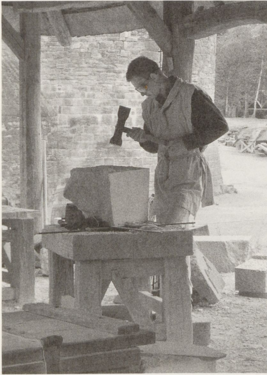
Abb. 3b: Steinmetz mit Zahnfläche, Baustelle Guédelon, © Stefan Bürger.
