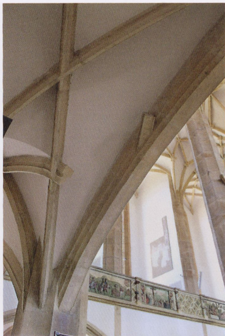
12 Kostel Nanebevzetí Panny Marie v Mostě, náběhy žeber s kazetovým profilem. © Thomas Bauer 2016.
