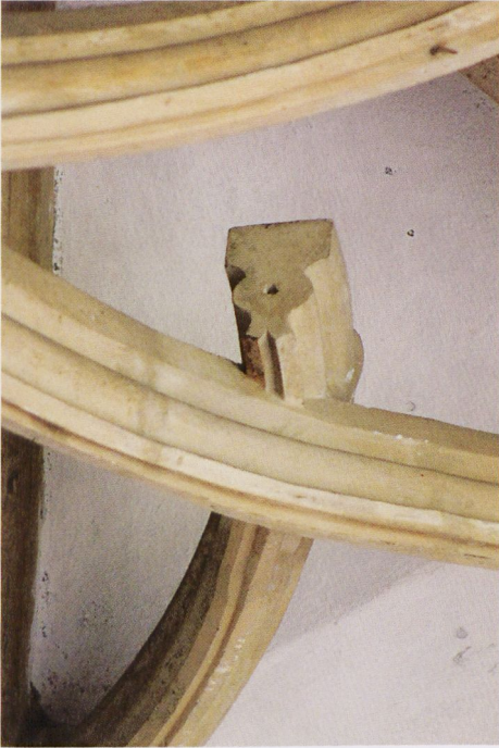
11 Himmelfahrtskirche Most, Rippenprofil mit gespaltenem Untersteg. © Thomas Bauer 2016.
