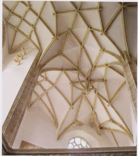
6 Himmelfahrtskirche Most, Gewölbegestaltung im südlichen Westjoch. © Stefan Bürger 2014.
