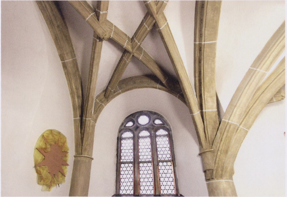
15 St. Marien Marienberg, kastenförmiger Scheidbogen im Westbau. © Thomas Bauer 2020.
