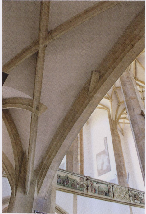
12 Himmelfahrtskirche Most, Rippenanfänger mit Kastenprofil. © Thomas Bauer 2016.
