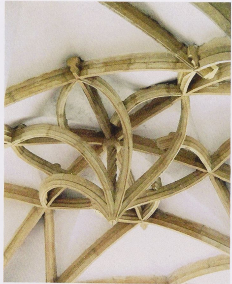
5 Himmelfahrtskirche Most, Gewölbegestaltung im nördlichen Westjoch. © Stefan Bürger 2014.
